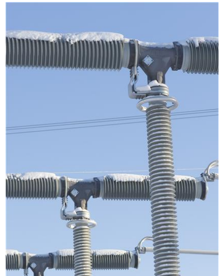
Figur 3.1 Effektbryter med fiberoptisk strømsensor (FOCS). Bildet er publisert med tillatelse fra ABB.
