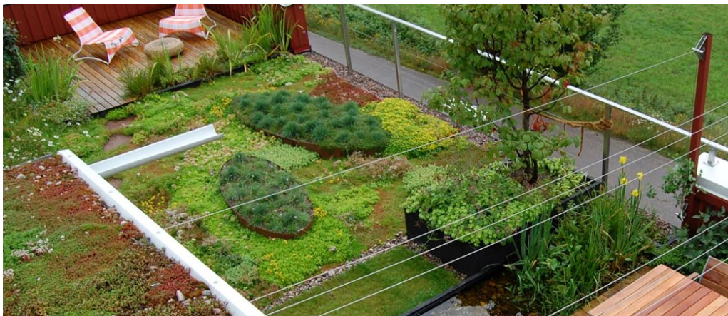
Figur 5-5 - Figuren viser et grønt tak. Konstruksjonen og vegetasjonen har lang levetid og krever lite vedlikehold i dette tilfellet. (Protan.no)
