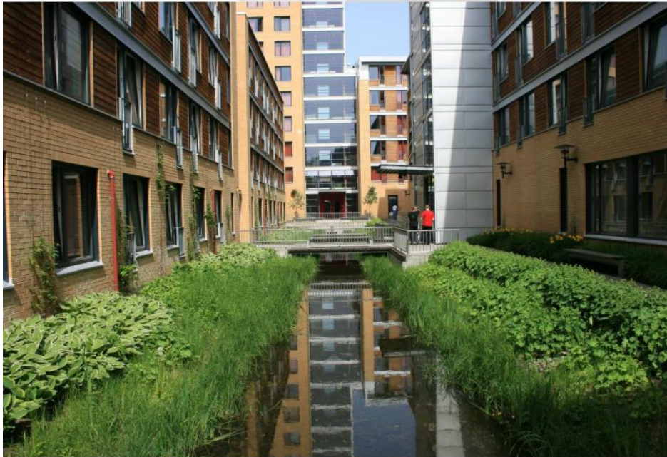
Figur 5-3 - Bildet viser hvordan en fordrøyningsdam kan utformes. Bildet er hentet fra Bjølsen, i Oslo.(COWI)
