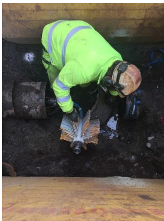
Figur 4.1: Sprøytehodet ved belegging i Uelands gate.
