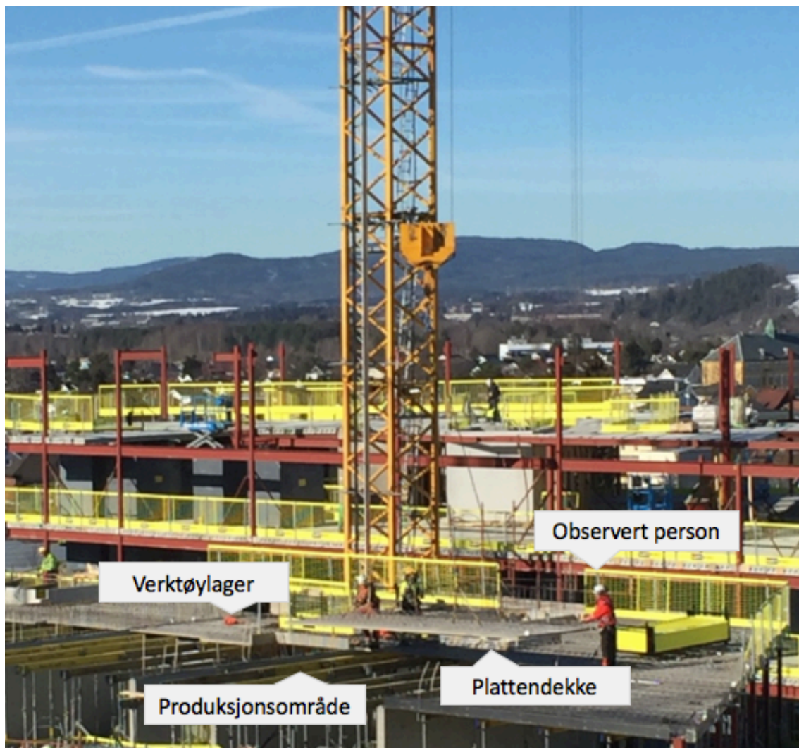
Figur 39: Oversiktsbilde over installering av plattendekker
