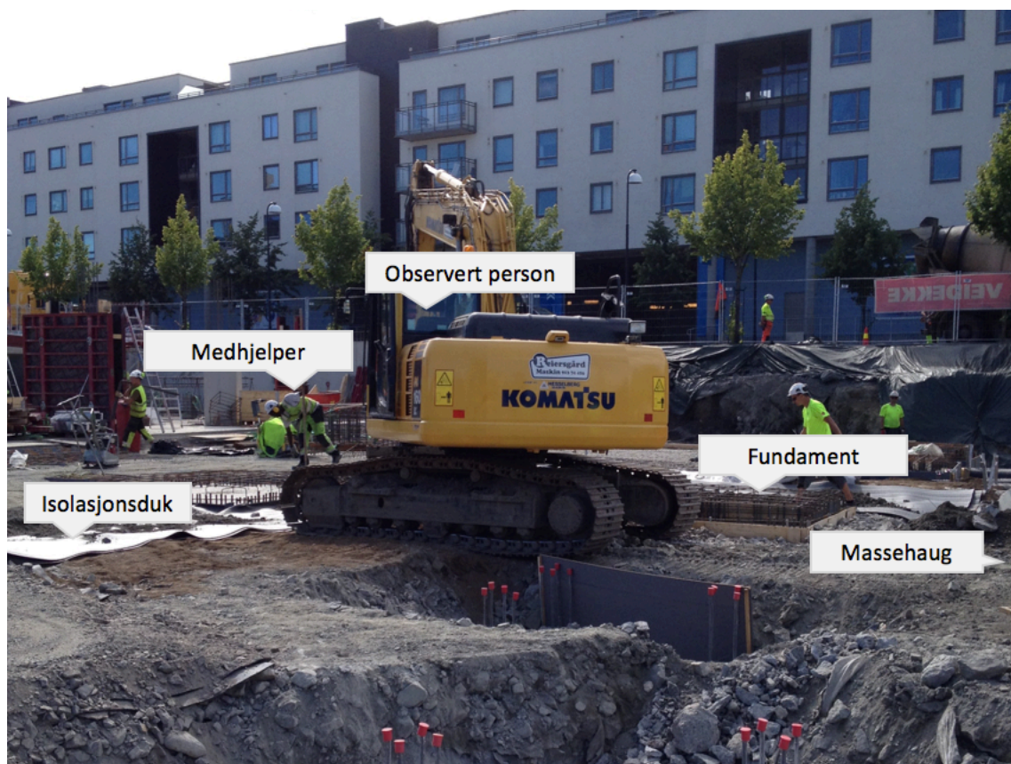
Figur 27: Oversiktsbilde over graving og oppfylling av grunn
