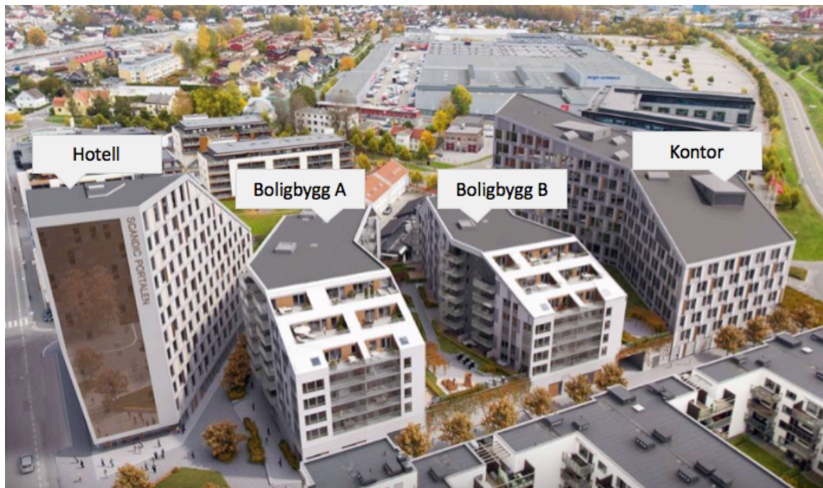
Figur 25: Byggene ved portalen (Veidekke 2016d)
