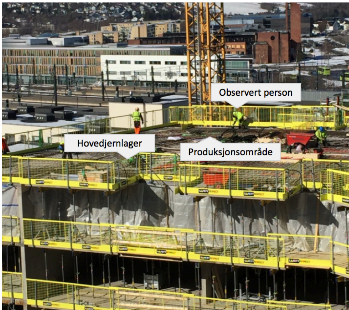
Figur 30: Oversiktsbilde over monteringen av armering
