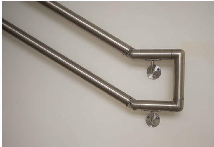
Figur 5.2: Håndløper av børstet stål. Figuren viser at materialer som børstet stål gir varierende grad av gjenskinn, og kan by på utfordringer ved måling og beregning av luminanskontrasten.
