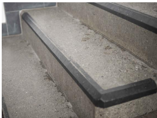
Figur 4.9: Slitasje på markeringer i trapp 12. Malte markeringer på trappeneser utsatt for stor slitasje. Til tross for avrundet kant, vil markeringen være lite synlig på vei ned i trappen. Trappen er en del av hovedårene i bygget, og prosjektet ble ferdigstilt i august 2014.
