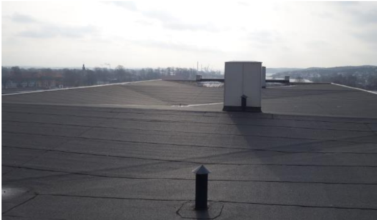
Figur 38 Ingen synlig skader på eksisterende tak plan. (Lu 2016)
