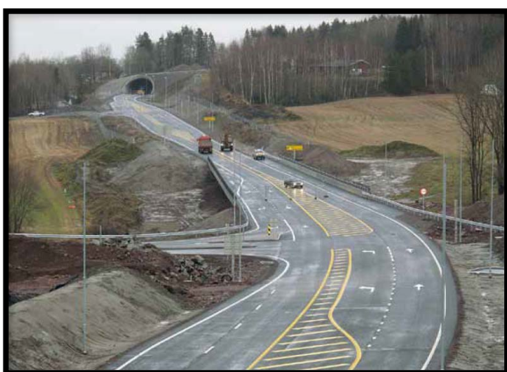
Figur 10: Rv. 306 Kirkebakken – Re grense – Foto: Statens vegvesen.
