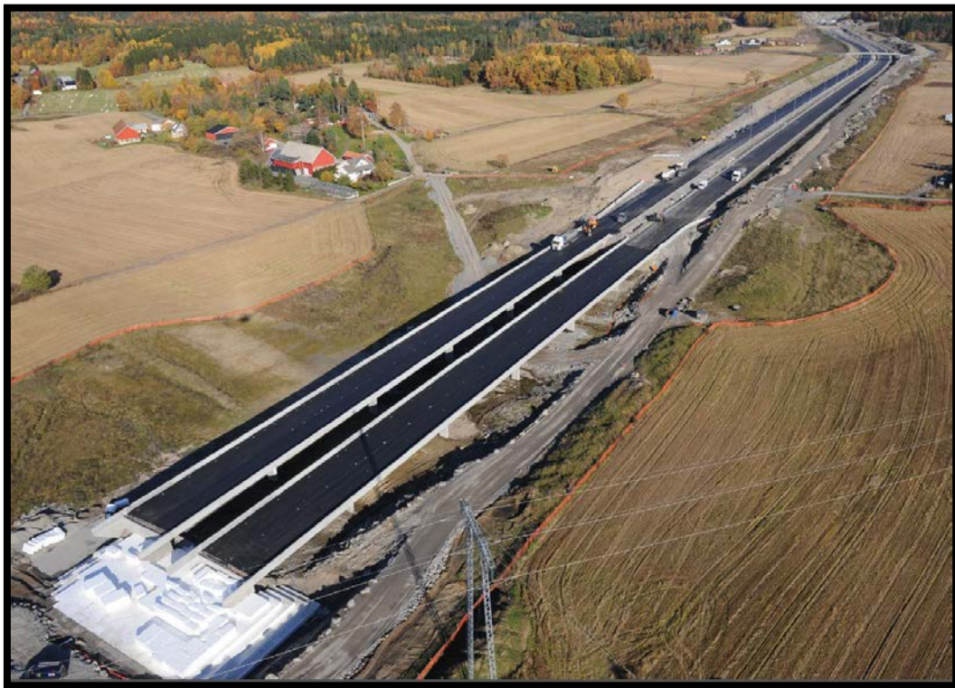
Figur 7: Flyfoto frå Statens vegvesen henta frå Statens vegvesen sitt arkiv. Bildet syner vegutbygginga av prosjektet E18 Langåker–Bommerstad..
