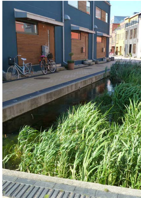
Figur 72: overvannshåndtering i gårdsrom
