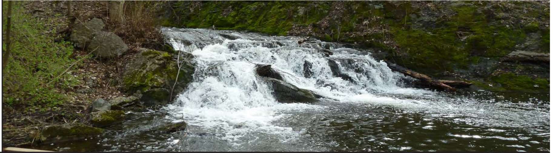
Figur 33: utløp av Bjørnebodammen
