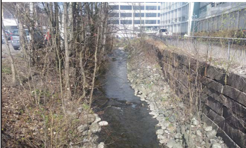
Figur 61: elva mellom Engebrets vei og trikketraseet i dag
