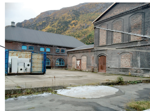
Figur 82: Ved at enkelte fasader er skjovet tilbake oppstår et mindre rom.
