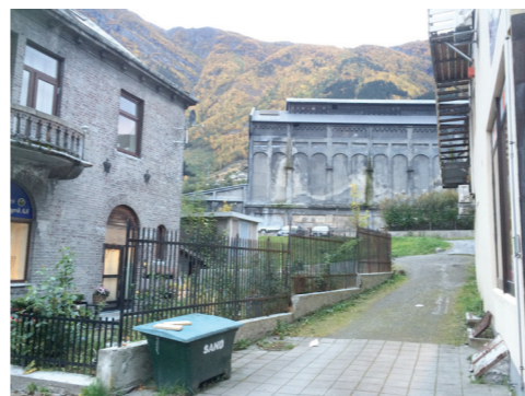
Figur 76: Mellom bygningene i gågata er det flere rom som skapt sammenheng opp til cyanamiden
