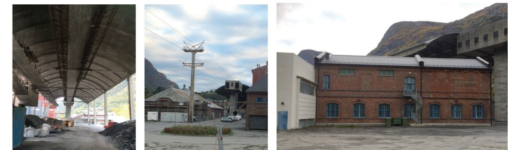
Figur 47: Skalltaket, masta til taubanen og trafostasjonen
