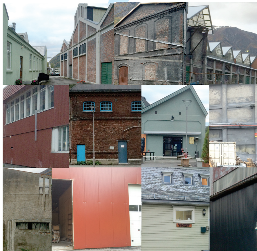
Figur 88: Bygningsmaterialer og fasader
