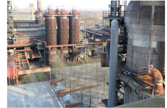
Figur 13: Enkelte områder er opprustet
