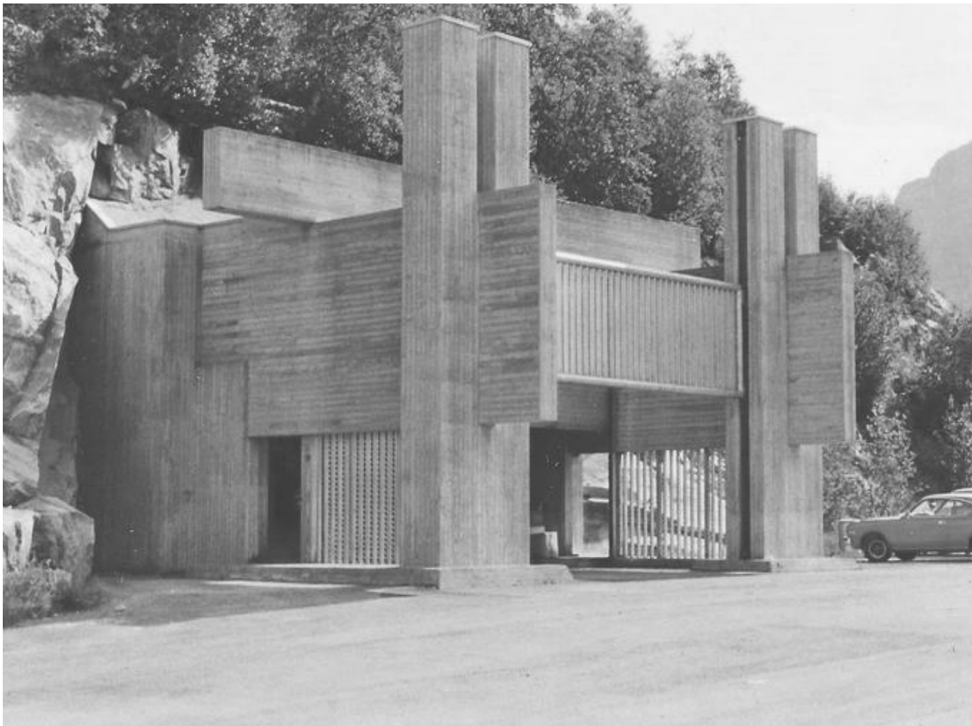
Inngangsparti til Tysso II, Tyssedal kraftstasjon. Tegnet av Geir Grung
