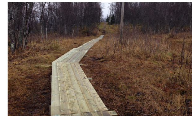
Klossing av våte partier. Foto tatt av: Henrik Romsaas
