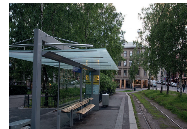
Fig. 104: Dagens sideplattformer ved Birkelunden holdeplass.
