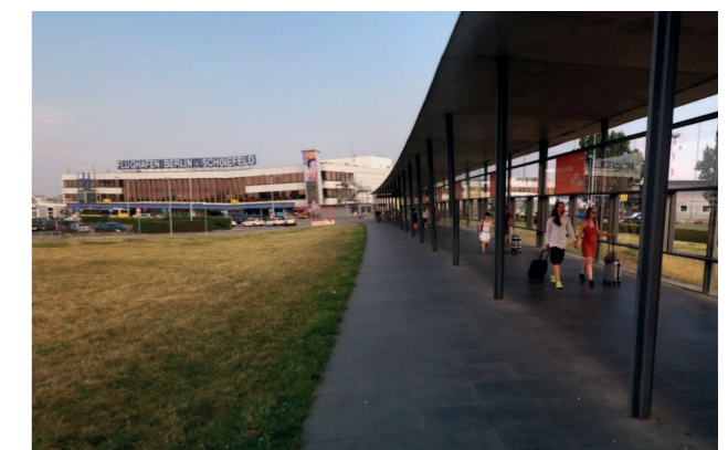
Fig. 177: En gangvei under en takkonstruksjon binder visuelt sammen to områder som ligger langt fra hverandre, ved Berlin lufthavn Schönefeld.
