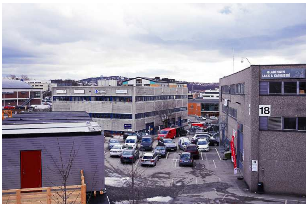
Bilde 5.6: Eiendommer som skal transformeres nord i planområdet. Tatt mars 2016.
