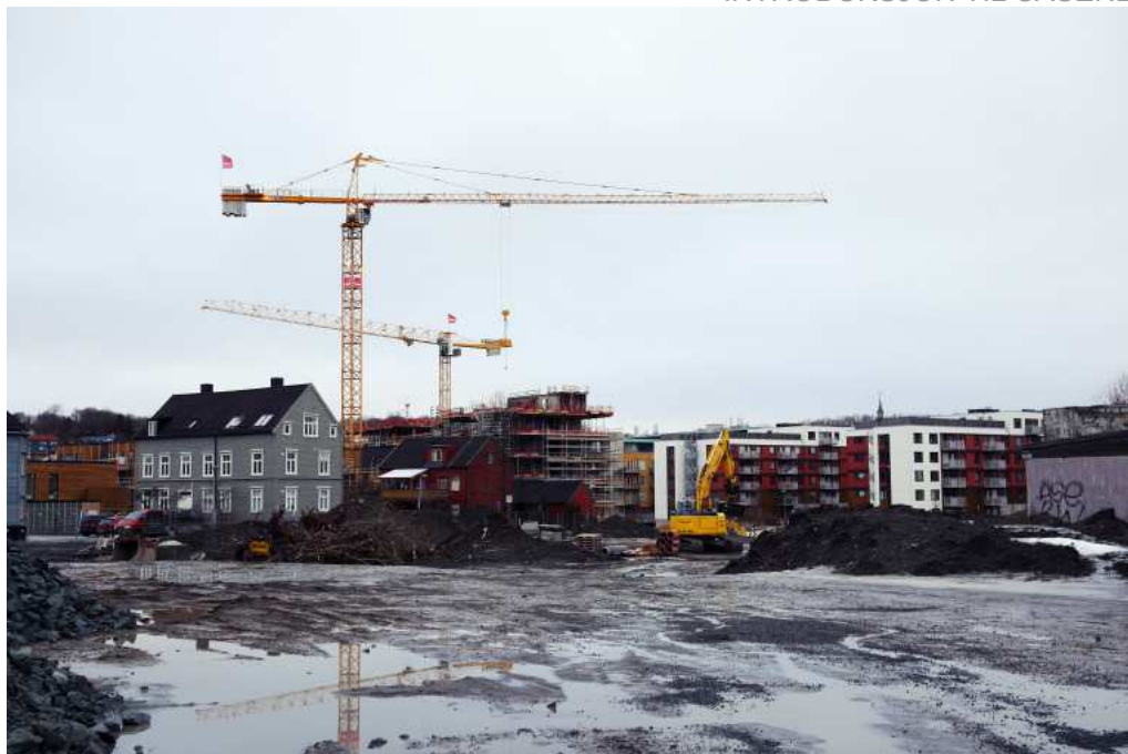
Bilde 5.12: De fleste gamle næringsbyggene er revet og bygging av boliger er i gang. Tatt mars 2016.
