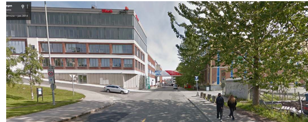
FIGUR 69: mack-bygningen og videre inn mot sentrum, sett fra strandvegen. kunstforeningen ligger til venstre.
