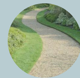
FIGUR 104: Stabilitert grus skal være belegget på stiene i parken. Grusen skal skilles fra gresset med en stålkant.
