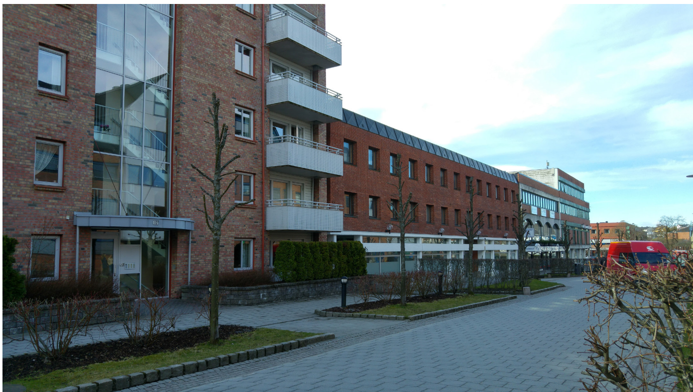
Figur 30 Eksempel på vertikalt skille mellom bolig og næring. Den høyere bygningen til venstre inneholder boliger mens bygningene til venstre inneholder butikker og kontorer
