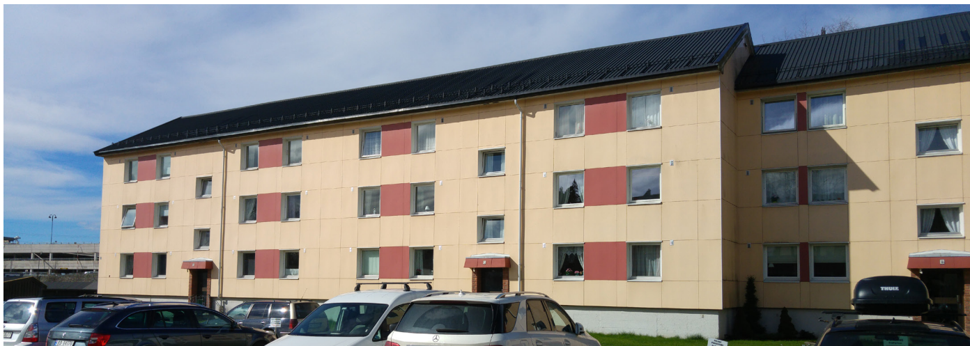
Figur 36 Eksempel på blokkbebyggelse sør i sentrum.
