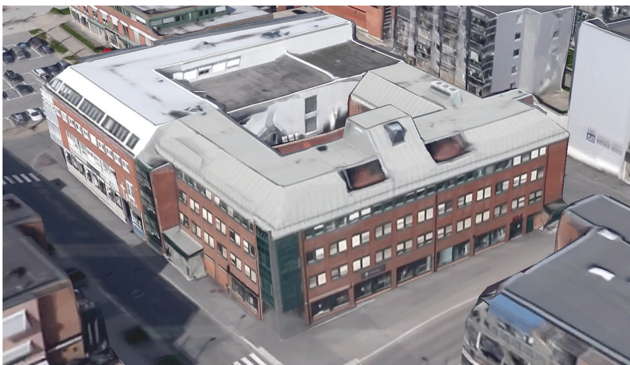
Figur 37 Eksempel på en takvariant med inntrukket øverste etasje og valmet fasong.
