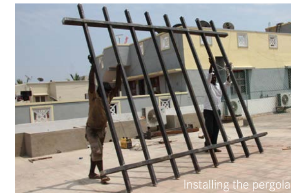
Installing the pergola.
