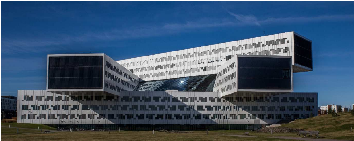
Figur 10: Statoilbygget sett fra øst. Kilde: C.Blix
