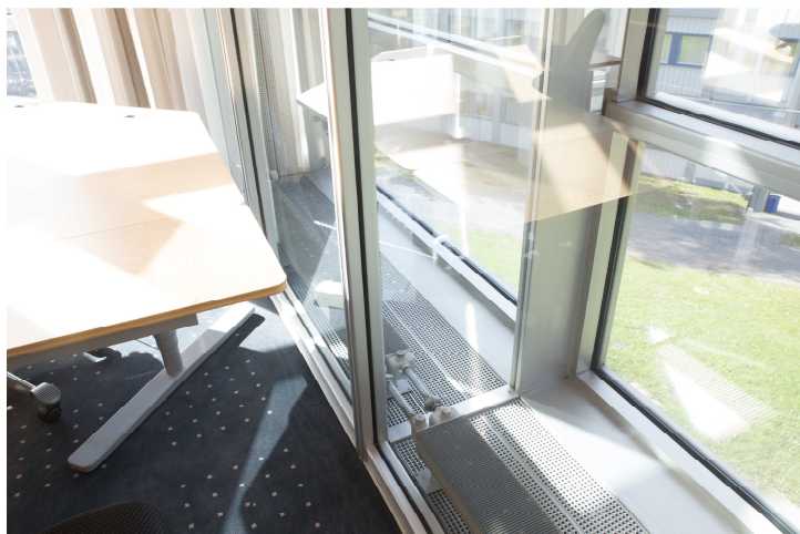
Figur 4: Vindusløsning i undersøkelsesområde. Doble glassfasader. Veritas I Kilde: C.Blix
