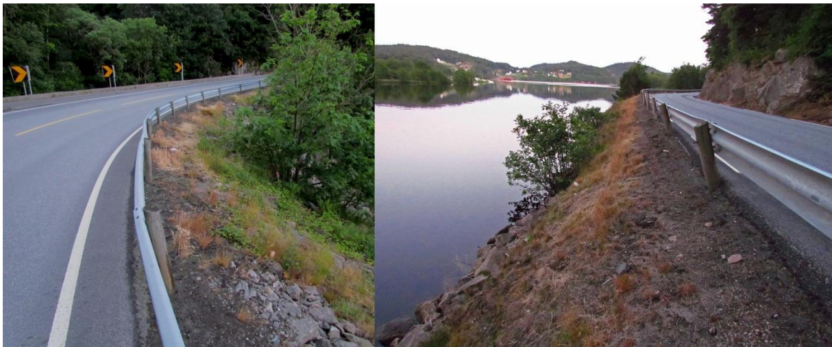
Figur 1: Sprøyting under vegskulder på et vegstrekk langs Fv 460 Vigeland – Spangereid (Kai Berggren 2012).
