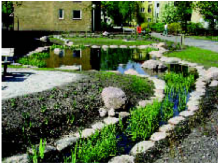
Bilde 2-1 Åpen overvannsløsning for boligområde (Statsbygg 2014)
