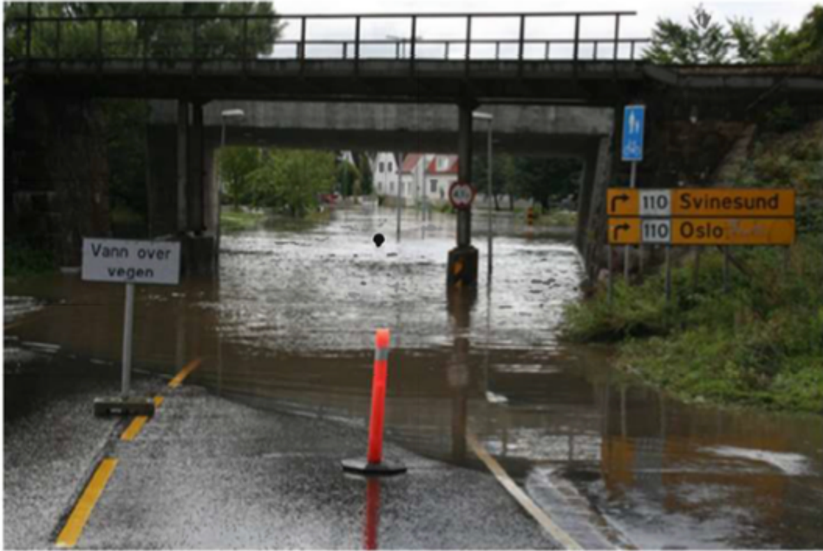
Bilde 1-1 Oversvømmelse av undergang ved jernbanelinjen i Holmegata ved flommen 14.08.2008. Overvannet kommer fra innløpet til Holmenkulverten som ligger ca. 180 m til høyre utenfor bildet. (Norconsult 2015b)
