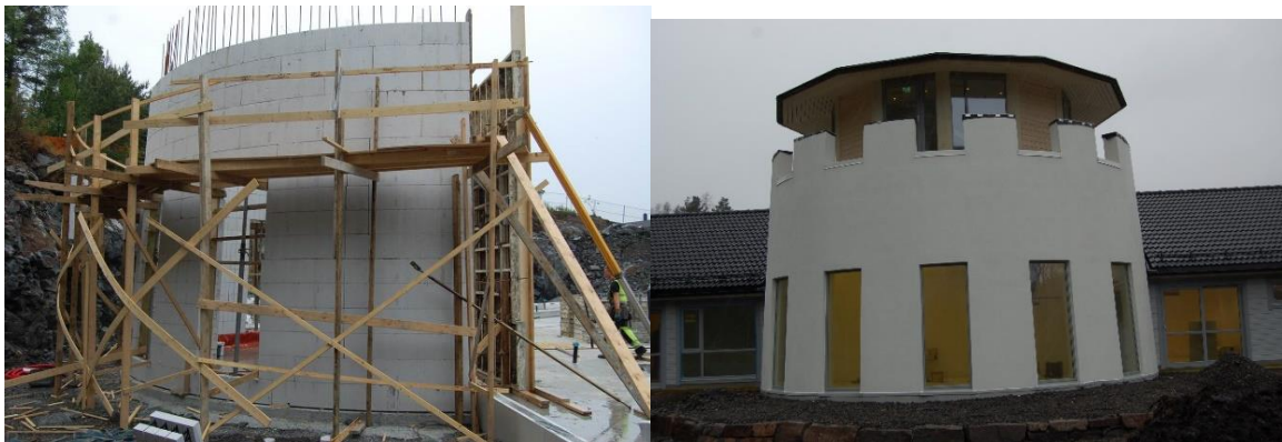
Figur 2 "Sokrates Tårn", en rund Thermomur før og etter støp
