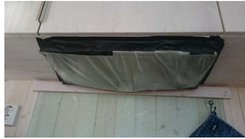
Figur 3-10: Tetting av kjøkkenhette. Foto: Tonje M. Tredal
