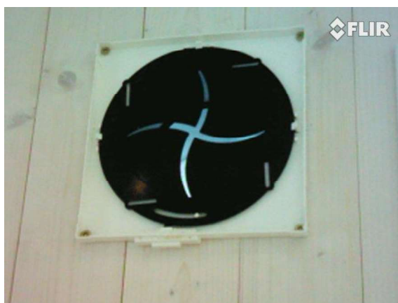
Figur 9-36: Spjeld, tilluftsventil, når det er tilnærmet lukket. Foto: Tonje M. Tredal
