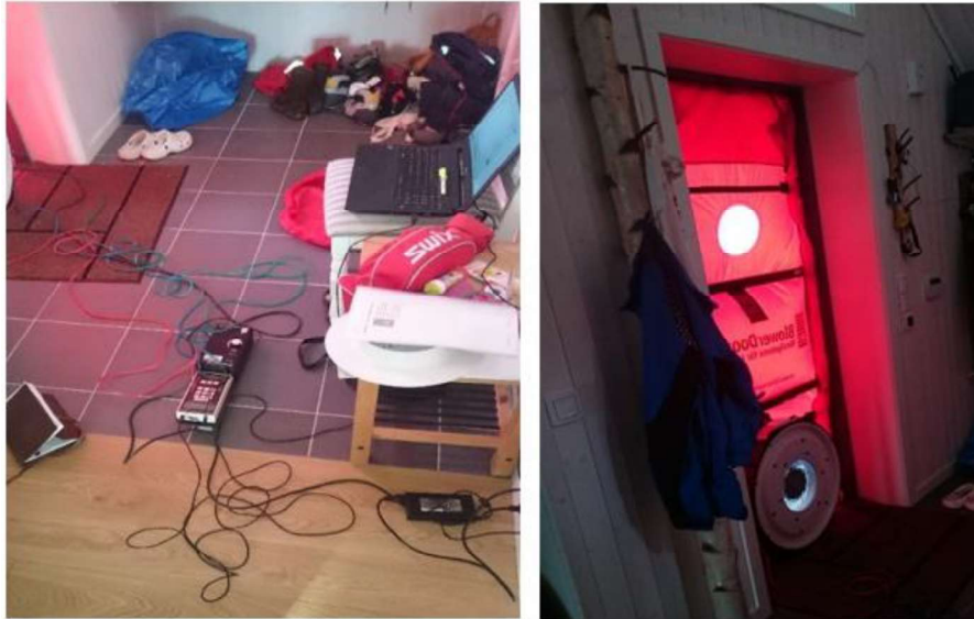
Figur 3-2: Blowerdoor-system installert i testbolig. Til venstre er DG700-apparatet med koblinger til vifte og PC. Til høyre er viftesystem installert i ytterdør. Foto: Tonje M. Tredal
