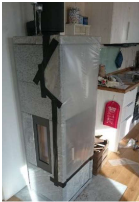
Figur 3-11: Tetting kleberstensovn. Foto: Tonje M. Tredal
