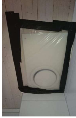
Figur 3-9: Tetting av avtrekk på bad. Foto: Tonje M. Tredal
