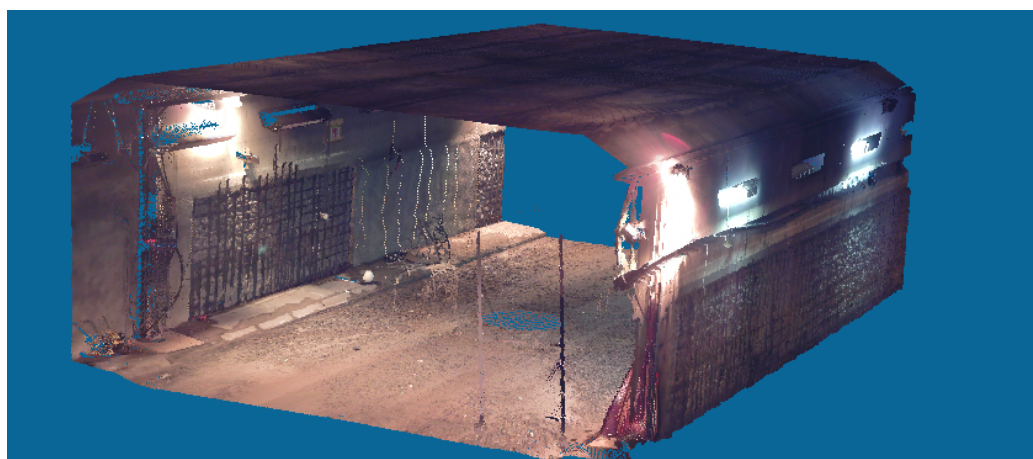
Figur 6.1: Utsnitt fra punktskyen etter laserskanning i Smestadtunnelen
