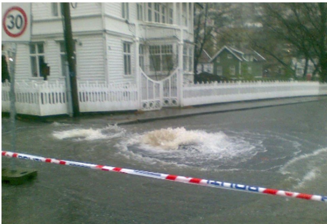
Figur 6: Eksempel på vann som strømmer ut av kum (Engan, 2014)
