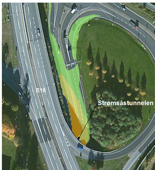
Figur 66: Nærmere utsnitt av Strømsåstunnelen
