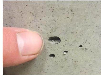
Figur 3-8 Døme på luftpore i ei prøve. Foto: Gunleiv Sæland
