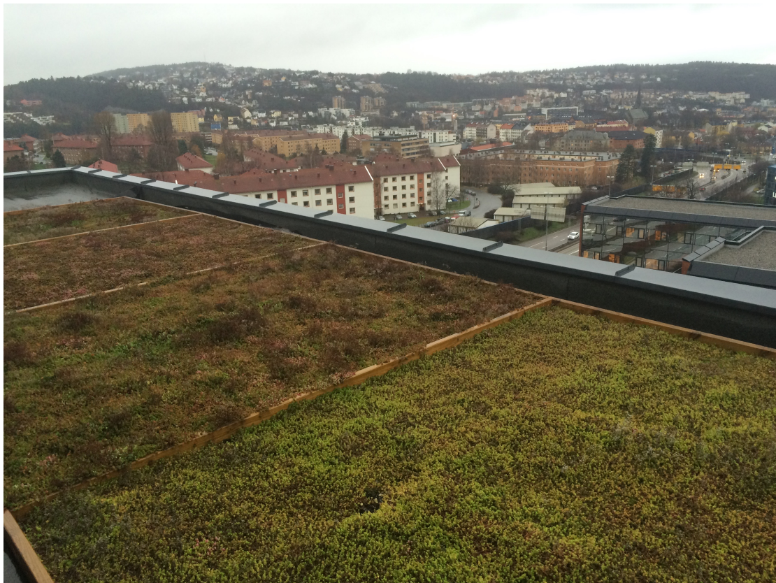
Figur 1: Ekstensive tak på toppen av Bymiljøtaten på Helsingør. Foto: Torkjell M. Jensen
