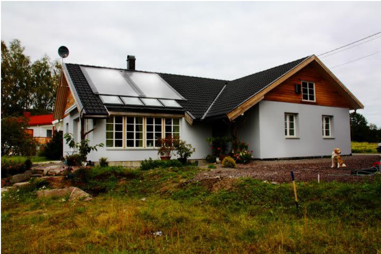
Figur 30. Bildet viser hvordan en ASV solfanger ser ut etter montering. (ASV Solar, 2015)
