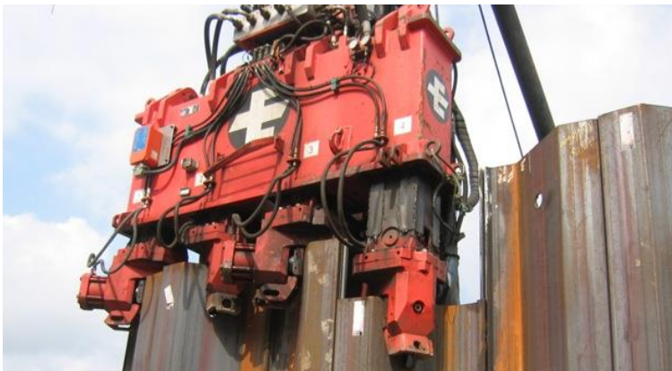
Bilde 3: Installering av "silent piling" Kilde: Entreprenørservice
