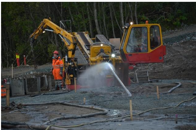
Bilde 14: Styrt boring utført av Olimb. Kilde: Olimb.no
