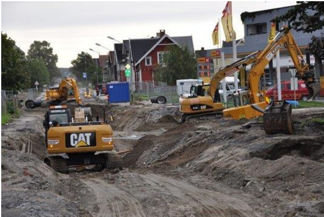
Bilde 9: Arbeid i Hønegata 01.09. 2009 uten forsinkelser. Kilde: Statens vegvesen.
