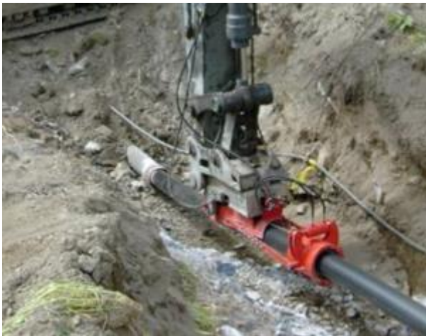
Bilde 12: PE rør føres inn i gammelt rør. Kilde: NPGnorge.no
