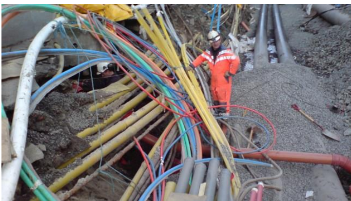
Bilde 2: Kabelkaos og nærføring. Foto Kristian Jonsen, Asplan Viak AS
