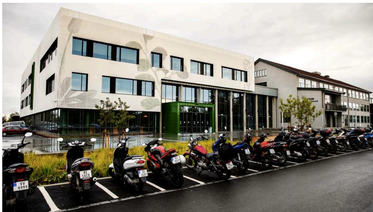
Bilde 6.4: Inngangspartiet til Strinda videregående skole (Adresseavisen, 2015).
