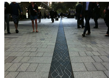
Figur 178. Drensrenne i mørk farge.
