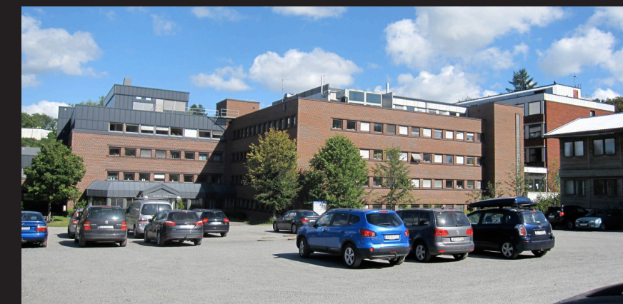
Fig. 3.34. Parkeringsplass mellom Saghellinga og Verkstedsbygningen.
