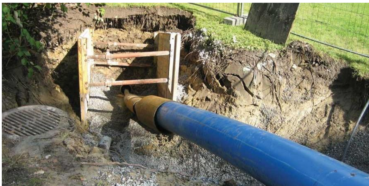
Figur 1: Ledningsfornyelse ved bruk av "NoDig-metode". (Samferdel & Infrastruktur 2015)
