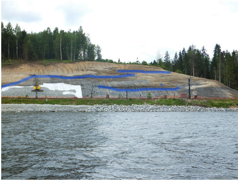
Figur 7-10. Bilder fra pleneringsarbeidet i juni 2013. Legg merke til den markante lagdelingen. (Jernbaneverket 2013).
