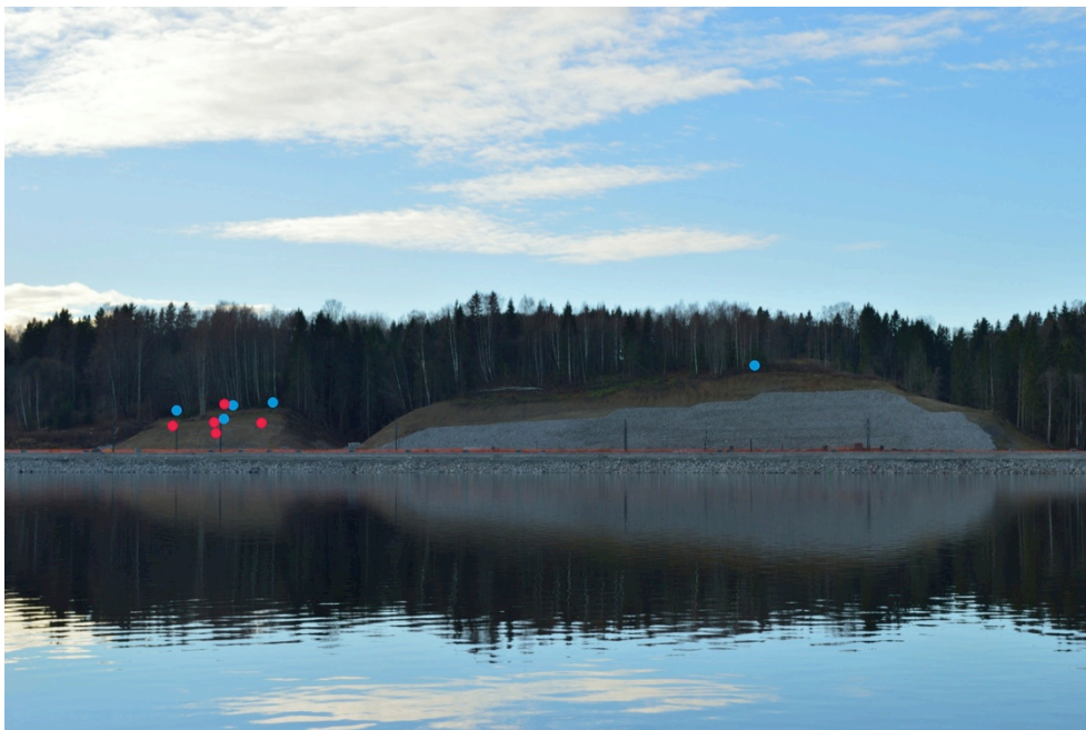
Figur 13. Skjæringene sett fra østsiden av Vorma. Blå punkter markerer plassering av grunnvannsbrønner, og røde punkter jordfuktsensorer. Tre av brønnenes plassering er ikke synlig på bildet da disse ligger lenger inne i landskaper og derfor er dekket av skog. (Aavatsmark 2013)
