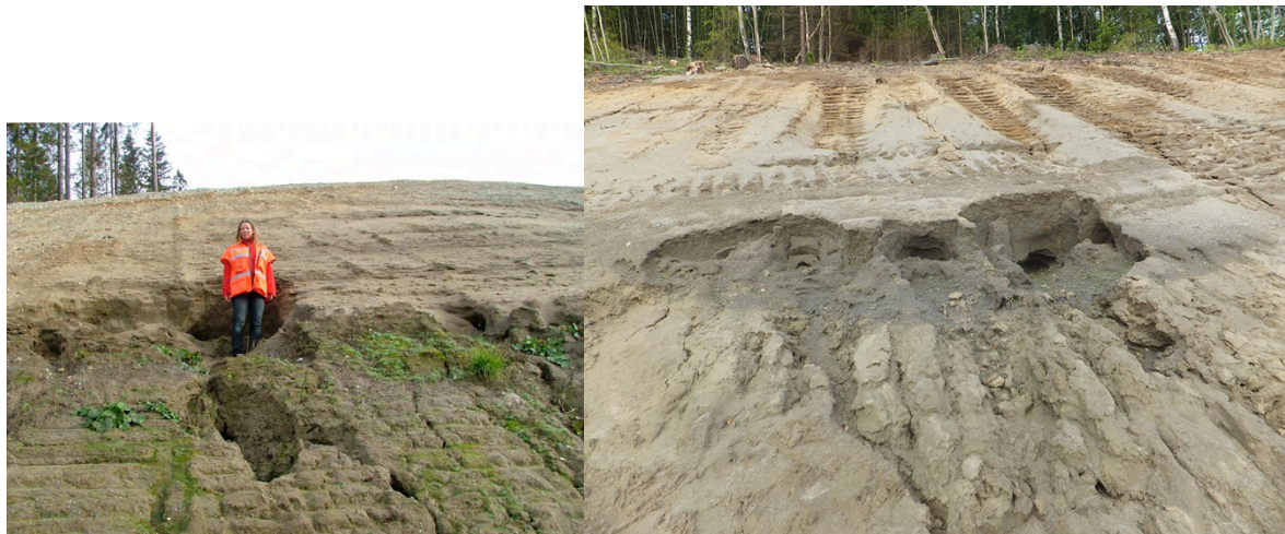
Figur 39. Til venstre et bilde fra HB274, eksempel på grunnvannserosjon (Foto: Hansen, T., SVV). Til høyre; bilde 4-5 meter fra toppen av stor skråning ved Eidsvoll (Foto: Jernbaneverket, 2013)
