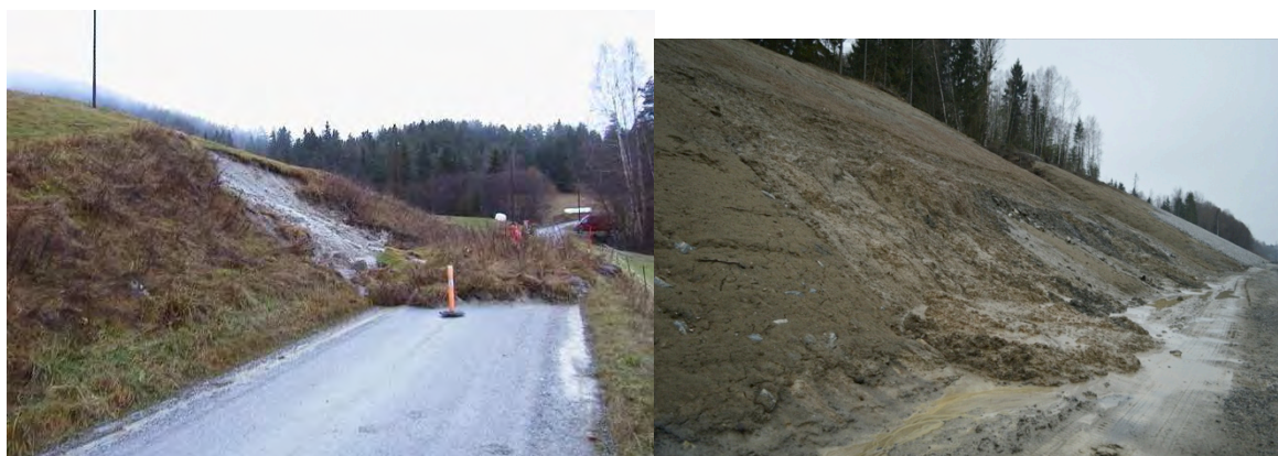
Figur 40. Til venstre et bilde fra HB274, eksempel på overflateglidning (Foto: Dolva, B., SVV). Til høyre; bilde av overflateglidning i liten skråning ved Eidsvoll (Foto: Aavatsmark, E.).
