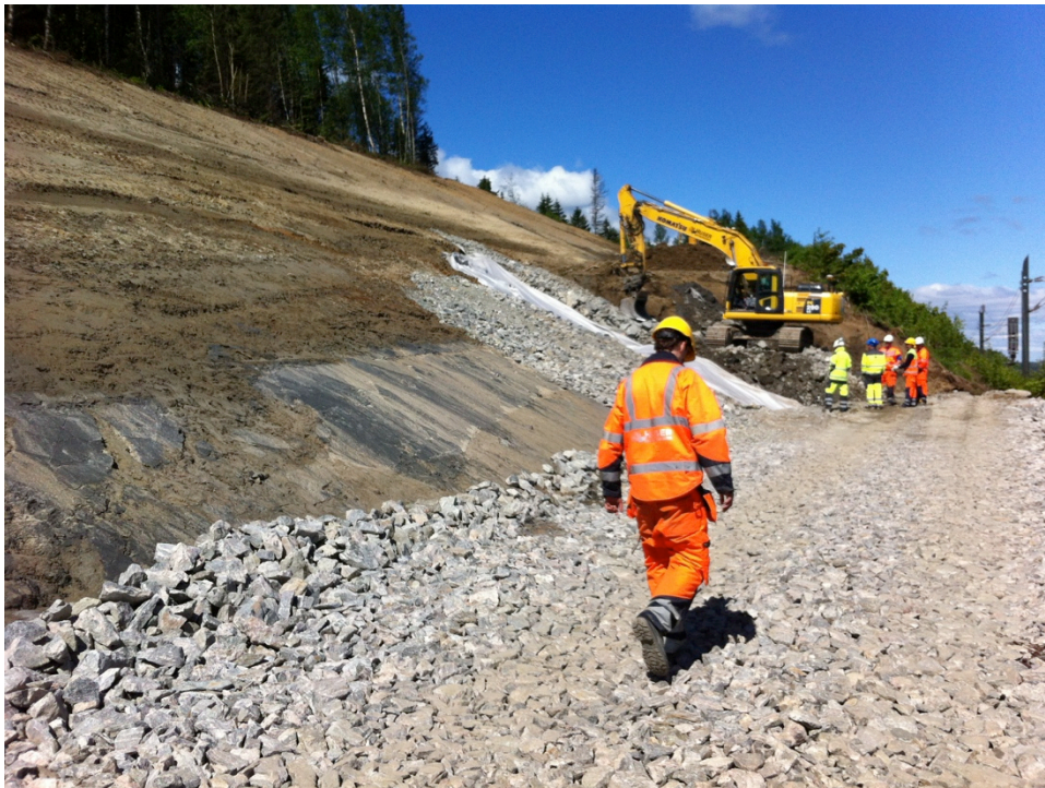
Figur 2. Bilde viser arbeidet med planering for å endre helningsgraden i den store skråningen 03.06.2013 (JBV 2013). Legg merke til den markante lagdelingen mellom leire, silt og sand, samt spor etter grunnvannserosjon midt i sandlaget.
