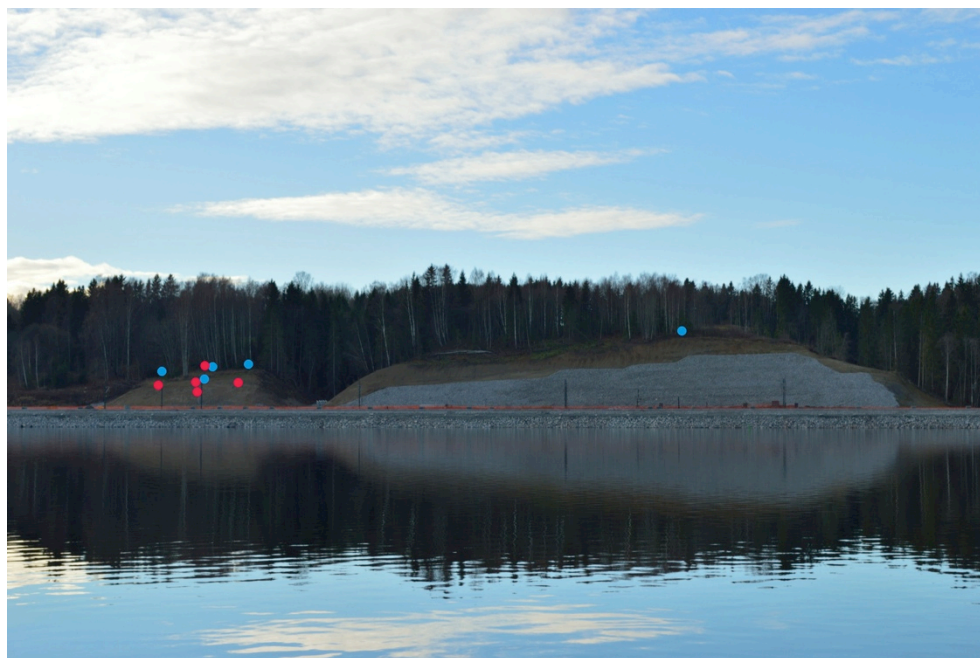
Figur 3. Skjæringene nord for Eidsvoll stasjon fotografert fra østsiden av Vorma. De røde og blå prikkene er beskrevet under avsnittet om metode. (Aavatsmark 2013)
