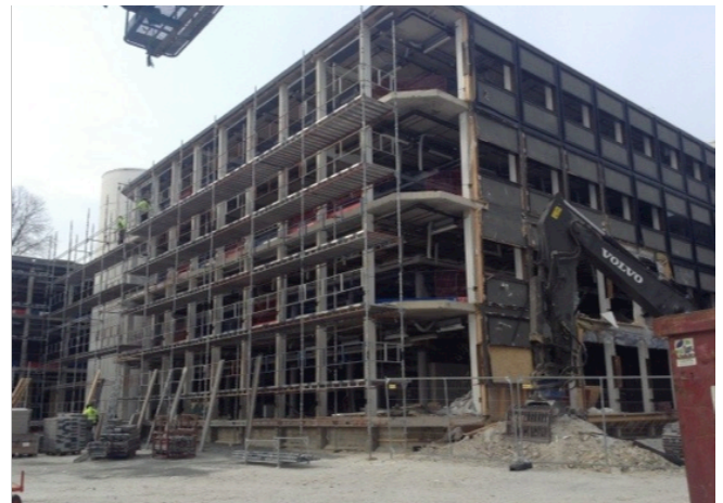
Figur 14: Powerhouse Kjørbo, råbygg under rehabiliteringen. (Skanska)
