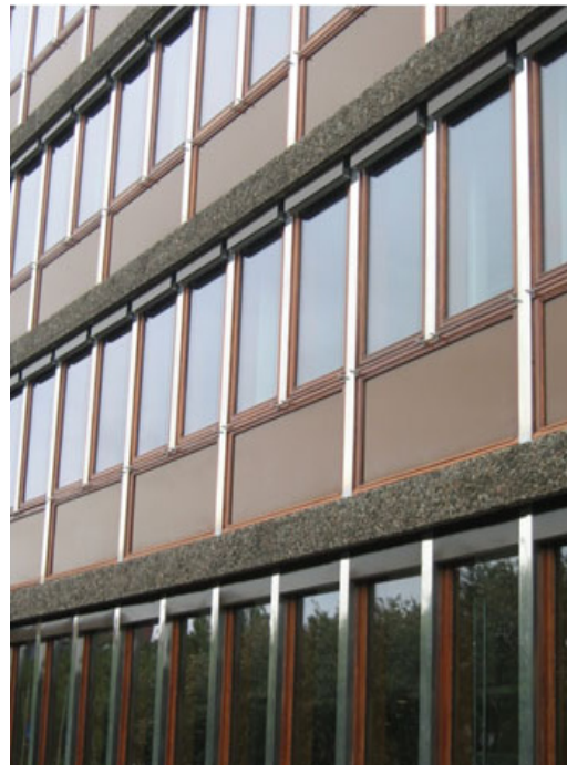
Figur 22: NVE-huset, persiener som utvendig solavskjerming. (Norgesvassdrag-ogenergidirektorat)
