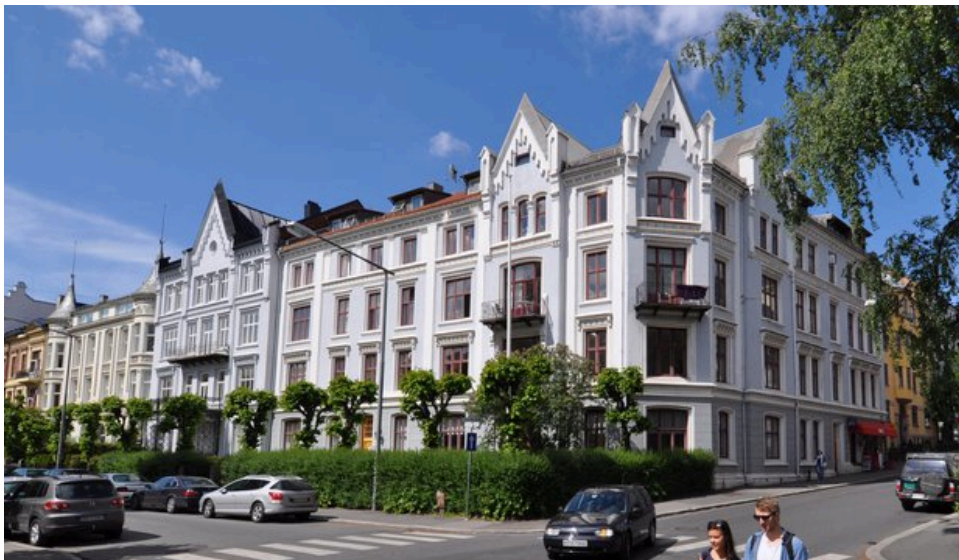
Figur 9: Oscarsgate 35 i Oslo er vernet etter plan- og bygningsloven.(Oscarsgate35AS)
