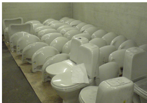
Figur 20: NVE-huset, gjenbruk av vannklosetter. (Norgesvassdrag-ogenergidirektorat)
