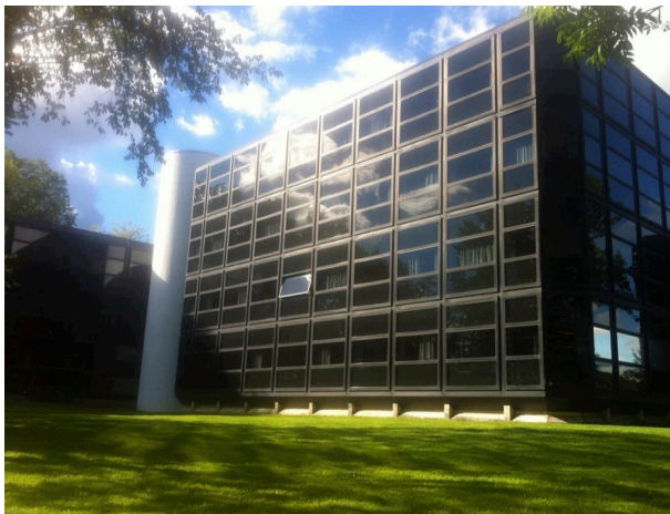
Figur 13: Powerhouse Kjørbo før rehabiliteringen. (Fornybar)
