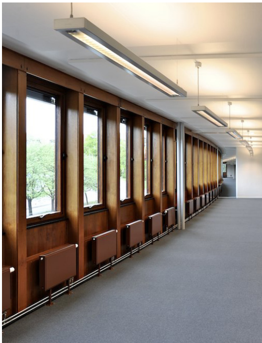
Figur 21: NVE-huset, radiatorer under vinduene. (Norgesvassdrag-ogenergidirektorat)
