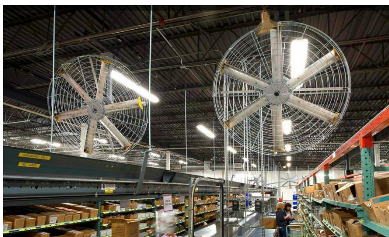
Figur 17: Justerbare takmonterte vifter
