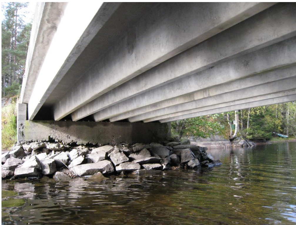
Figur 2: En betongbjelkebro med betongdekke som krysser Raudsjøen i Østmarka. Foto: Ole Stabekk, 2013.
