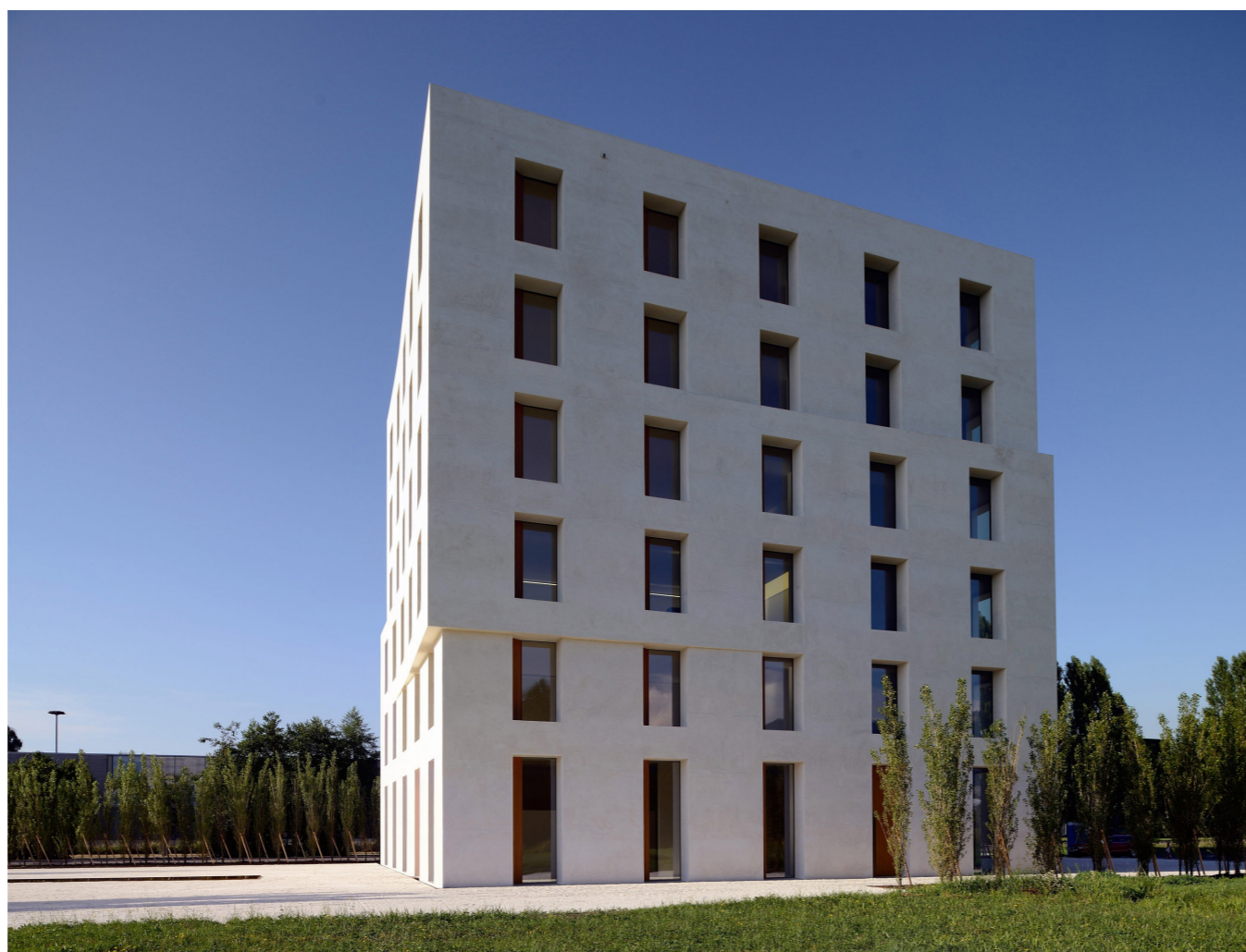
Foto: Kontorbygget "22/26" (Baumschlager-Eberle, 2013).
