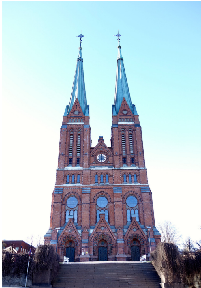
Foto: Skien Kirke. Det nygotiske bygget sto ferdig i 1894 og er etter norske forhold unik med sine to spir. Kirken danner utgangspunktet for nord/ sør-aksen gjennom byen.
