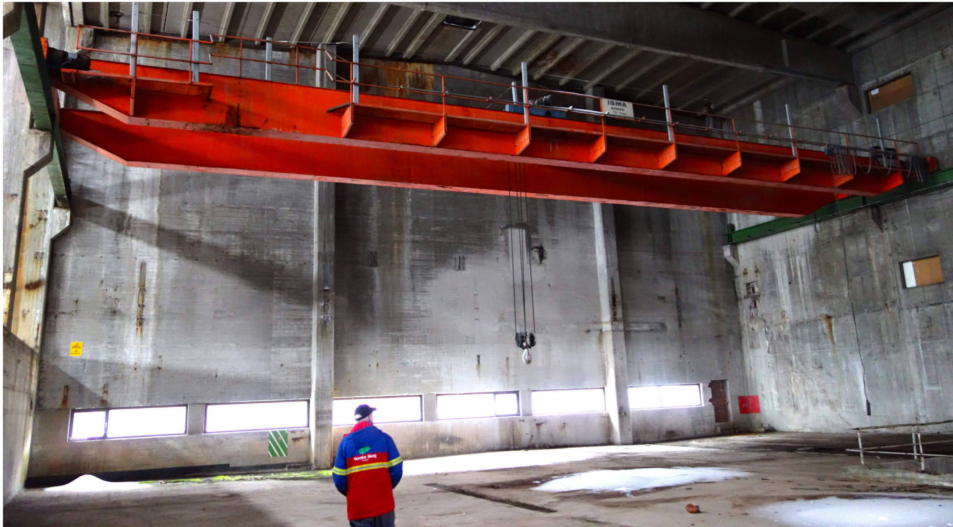
Foto: Den originale traverskranen i tilsynelatende god stand. På foto er også vaktmester Bernt Arnesen.
