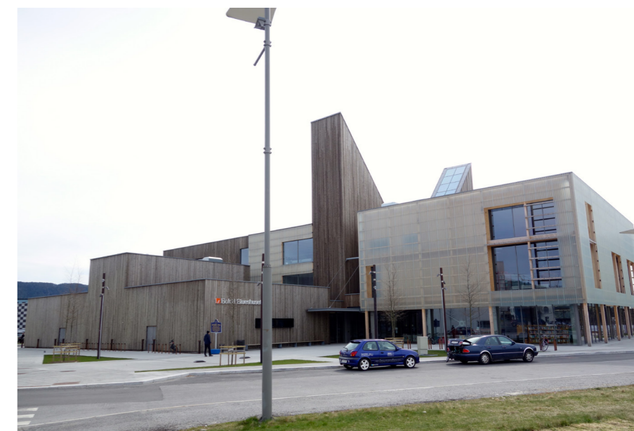
Foto: Kulturhuset "Bok og Blueshuset" på Notodden. Legg merke til lysinnslippene. Prinsippet tas igjen i Cellulosen.
