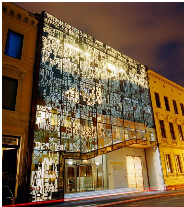
Figur 19. Bilde av glassfasaden til Lærernes Hus i Oslo. Her blir glassfasaden og spesielt bokstavutsmykningen brukt som solfangere (Oslo kommune).
