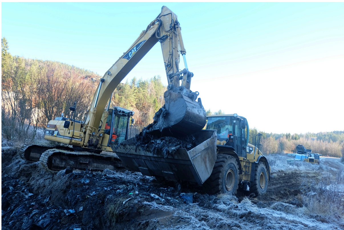
Figur 12 Avfallet blir plassert i dumper for transport til container. Foto: Knut Erik Haugen
