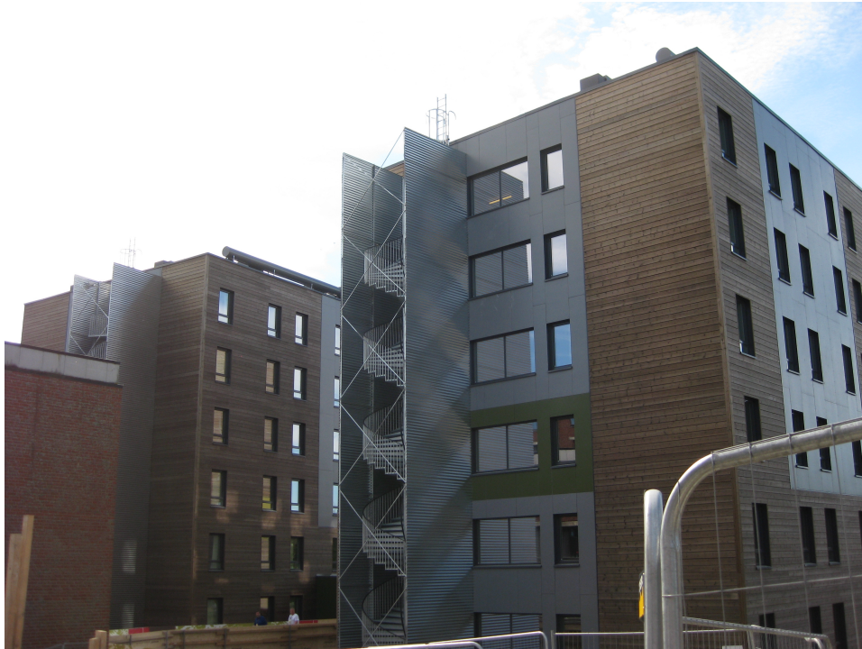
Figur 4.2: Bygga sett frå aust. Mottakarane blei plassert på kanten av taket på begge bygga.
