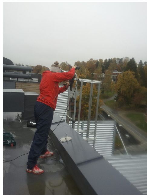
Figur 4.4: Lange skruer måtte til for å få godt feste eit stykke ned i massivtreet
