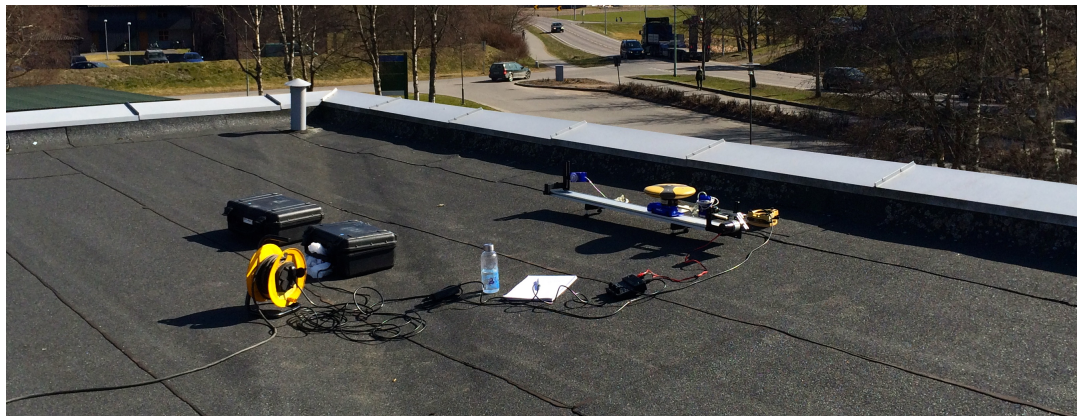
Figur 4.5: Oppsett av utstyret på taket av TF fløy 3
