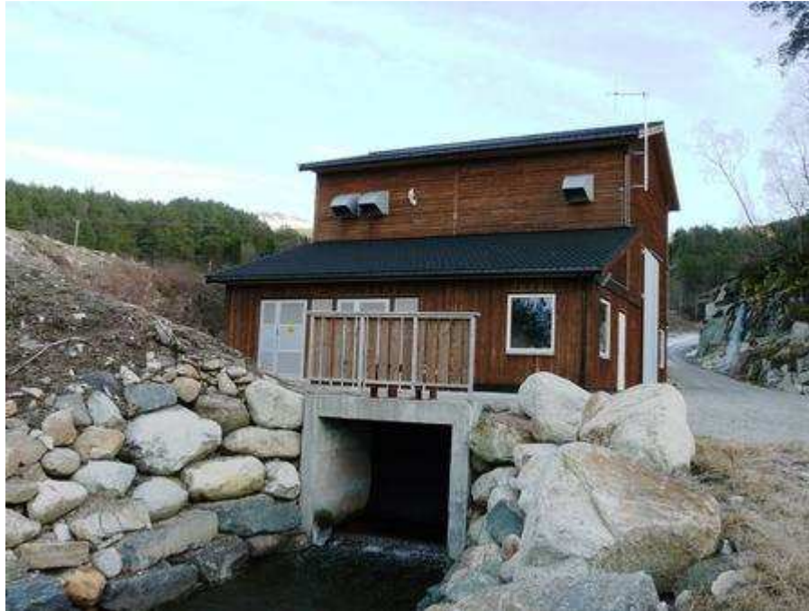
Figur 1.2: Bildet av et småkraftverk (Småkraft, 2014)
