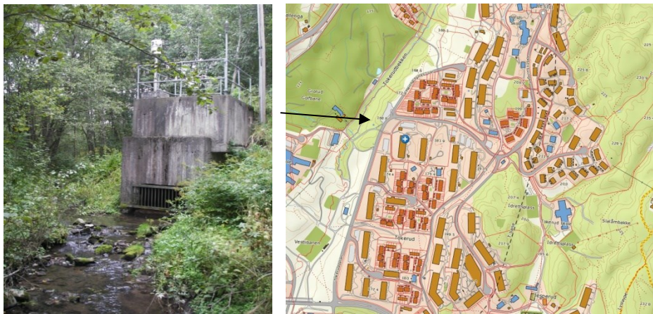
Figur 4.3: a) Bildet til venstre viser urbanstasjonen på Vestli(Møen 2014). b) Bildet til høyre er kart over Vestli, overvannet dreneres til urbanstasjonen i et separat ledningsnett.
