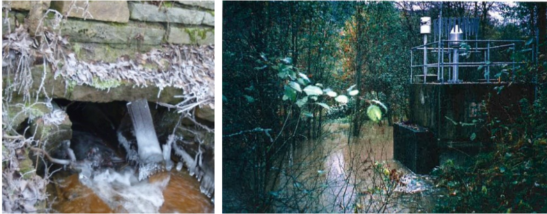
Figur 11.4: a) Bilde til venstre viser stikkrennen 39 meter nedenfor V-overløpet. b) Bildet til høyre er tatt mens det er oppstuvning i Tokerudbekken utenfor V-overløpet.
