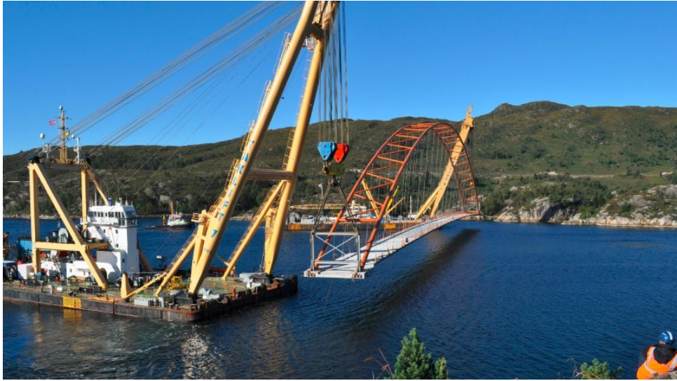
Figur 3: Transport av Brandangersundet bru fra Sløvågen.
