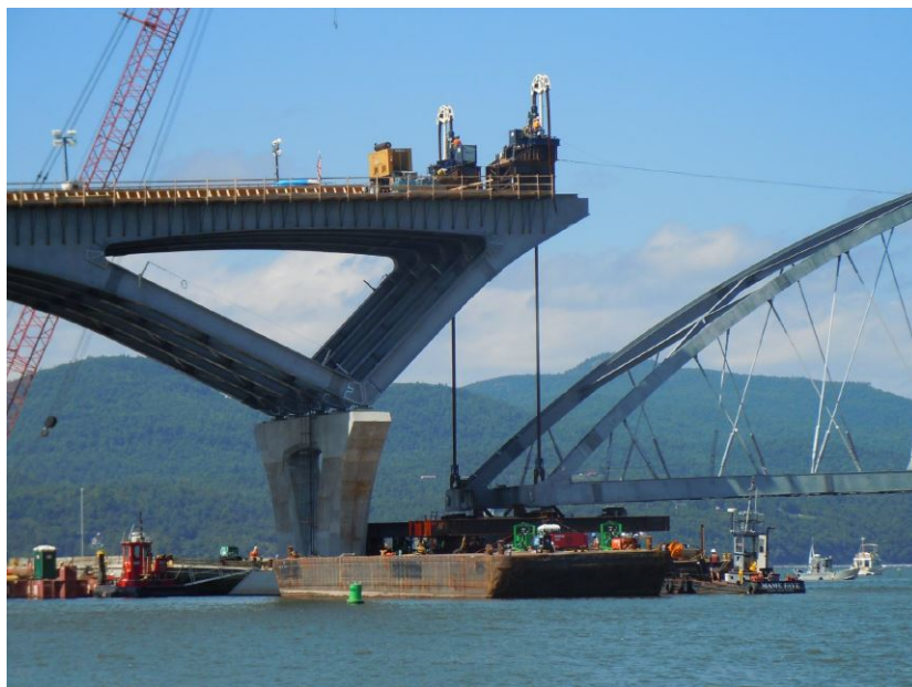
Figur 20: Heising av nettverksbru ved Lake Champlin (USA).
