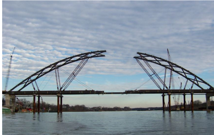
Figur 21: Stickbuilding av nettverksbruen Blennerhasset, Ohio (USA).
