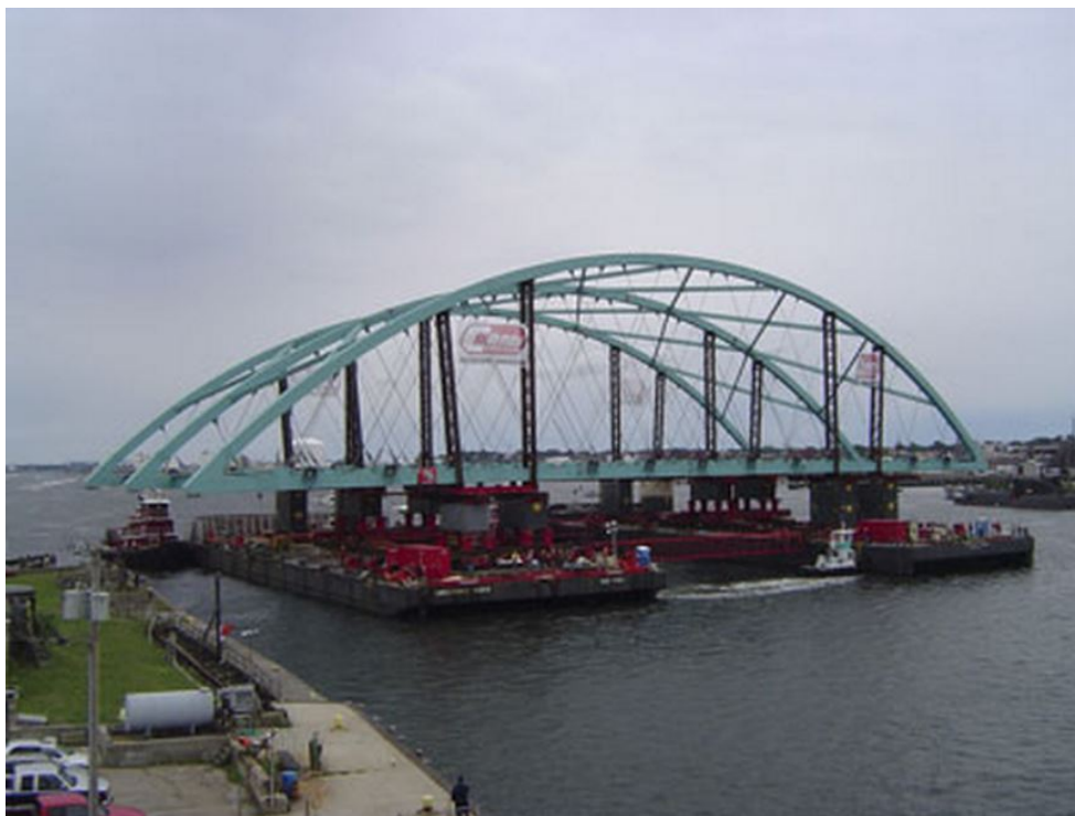
Figur 18: Float inn av Rhode Island's Providence River bridge (USA).
