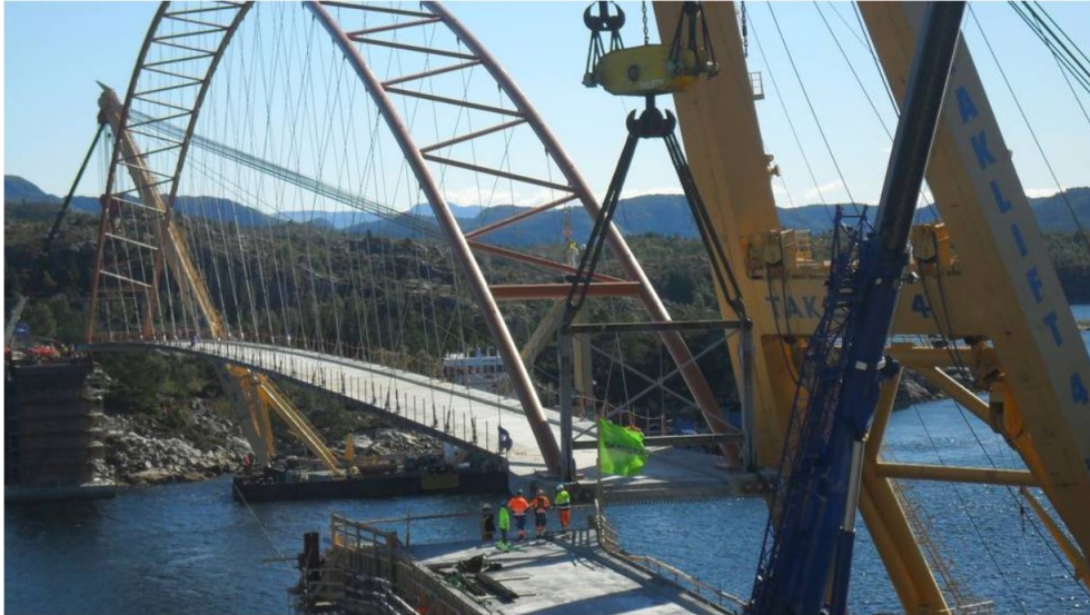
Figur 19: Transport av Brandangersundet bru med to shearleg kraner (Norge).
