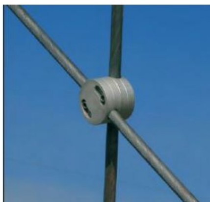
Figur 15: Beskyttelsesmekanisme for å forhindre friksjon mellom brukablene.
