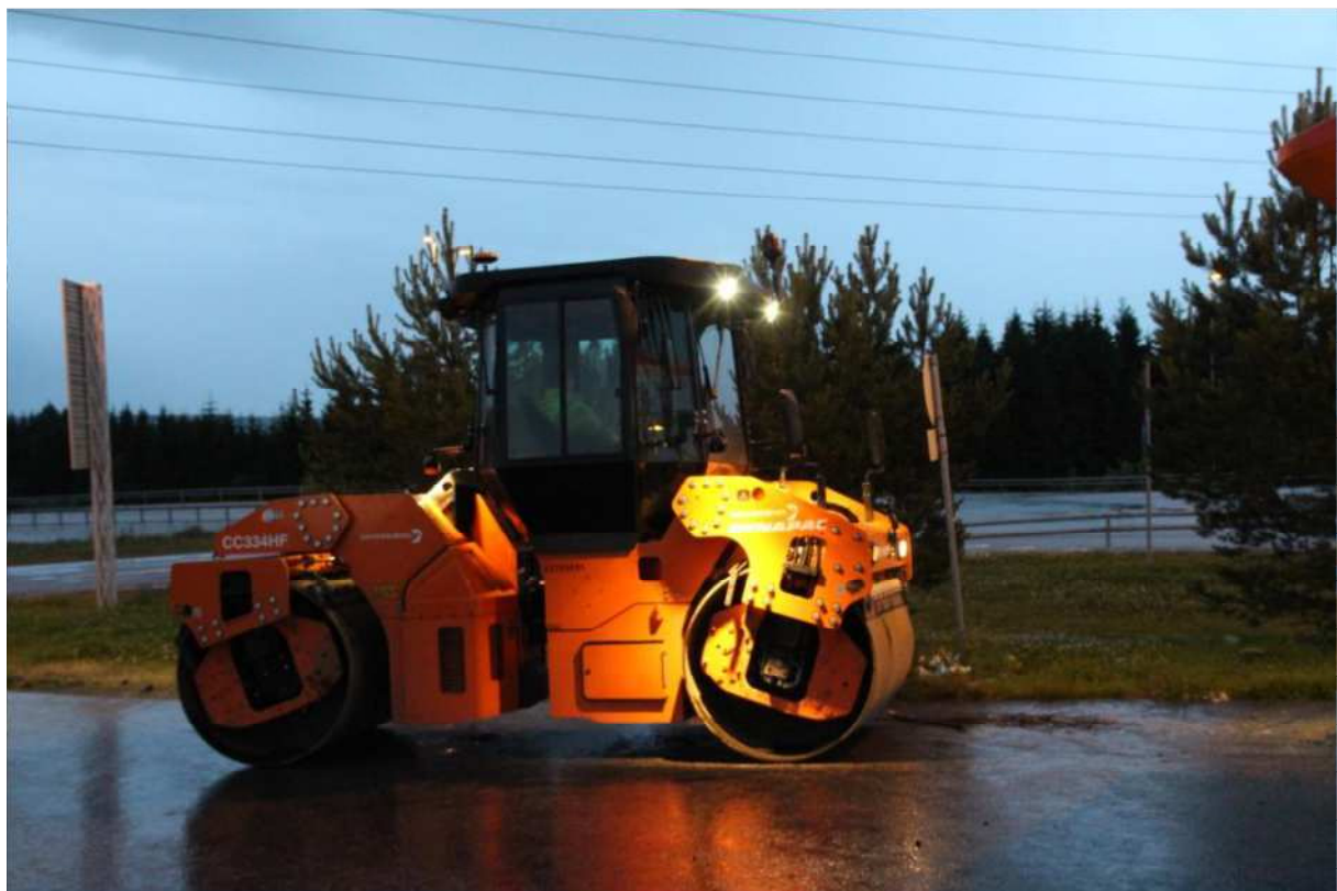
Figur 35 Bilde av vals fra Dynapac som ble nyttet under dekkeleggingen. Foto: Karoline Vaager
