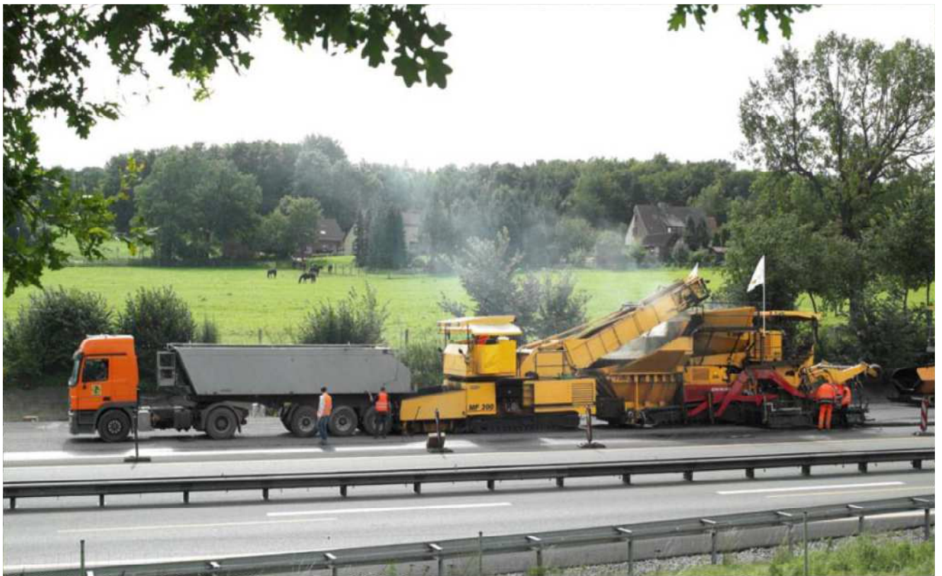
Figur 2 Viser hvordan asfalten leveres fra trailer, over i en feeder, som så leverer asfalten jevnt frem til utlegger. (Dynapac 2008)
