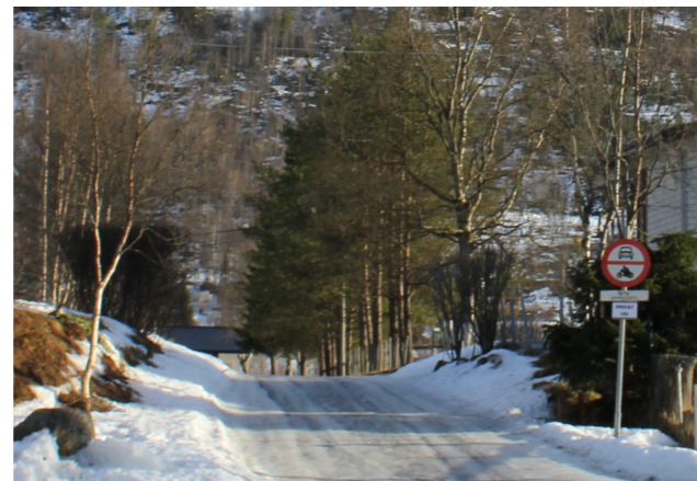
Figur 3.53 // Stornesveien sett mot øst, februar 2014
