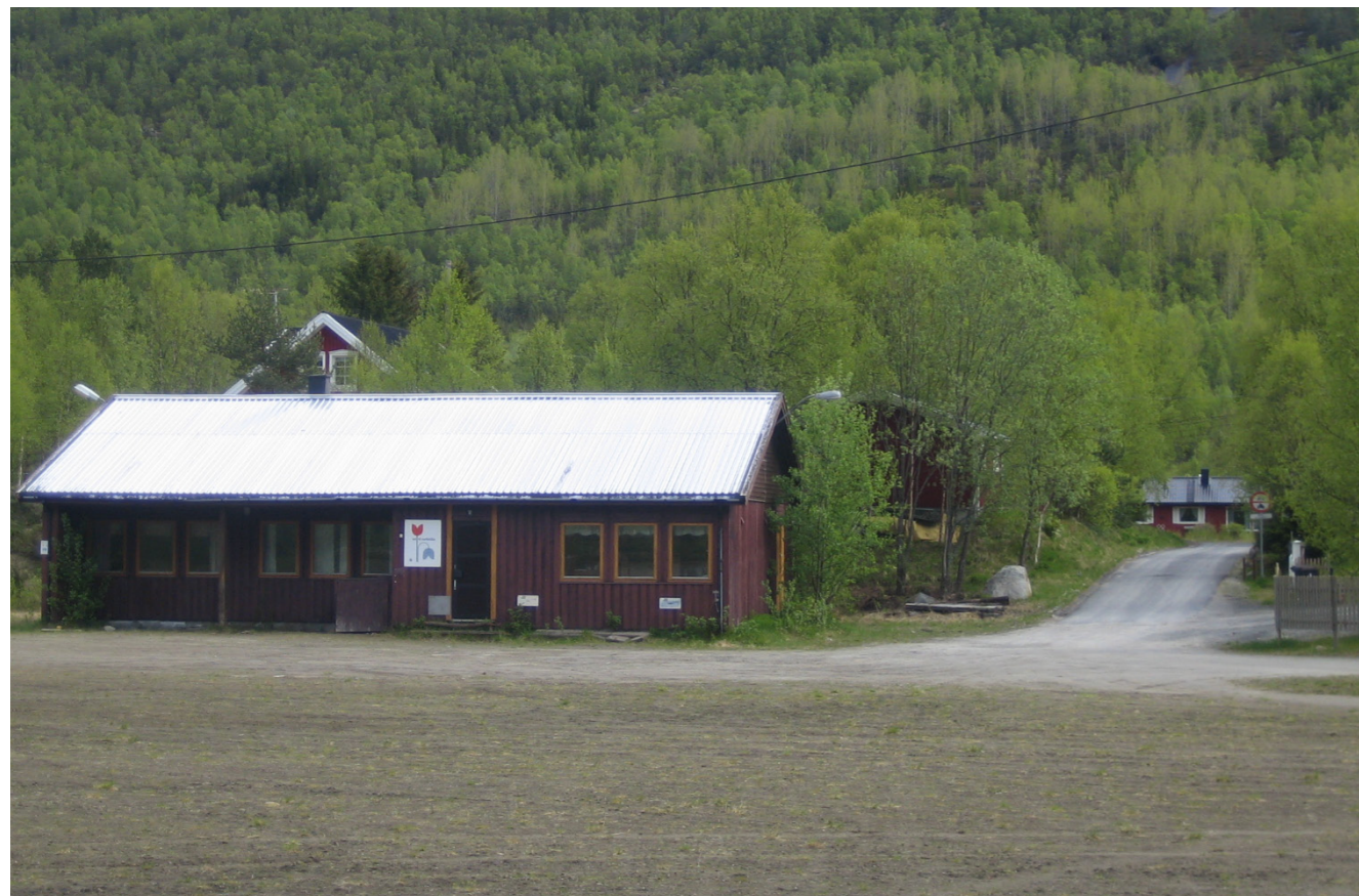
Figur 3.86 // Den tidligere idrettsplassen står i dag igjen tom og åpen
