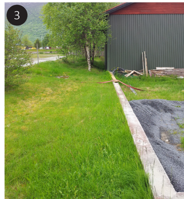
Figur 3.95 // Grunnmur til latrine, 22.06.2011
