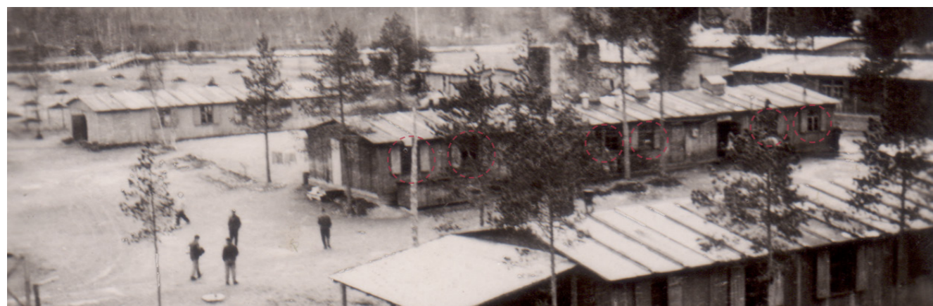
Figur 3.44 // Øverst: Snitt-tegning av en typisk håndtverksbrakke. Ca. 20 m lang. Figur 3.45 // Nederst: Kjøkkenbrakke i Beisfjordleiren med likt antall vinduer og dører som tegningen over, men kjøkkenbrakken er litt lengre.
