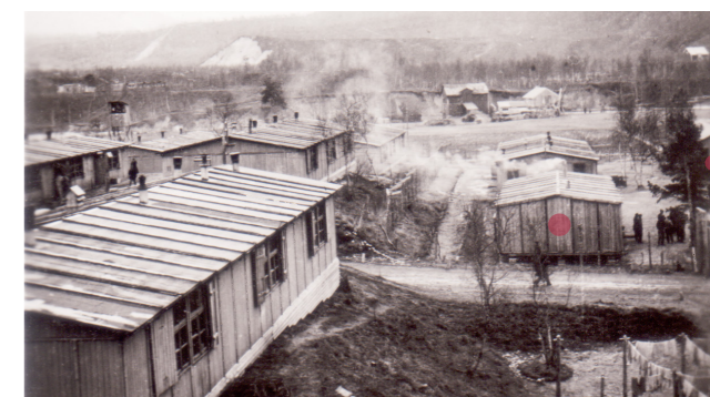
Figur 3.35 // Bildet er tatt fra det midterste tårnet i nord og viser leiren mot sør i 1945-46. Den fremste av de to mindre brakkene (merket med rød større prikk) kan ikke ses på tidligere bilder fra 1942-43. Det samme gjelder det som trolig var en av latrinene (merket med mindre rød prikk)
