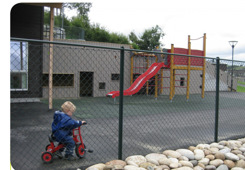
Figur 29. Et godt gjerde er for høyt til å klatre over, har forsterkning på toppen og oppleves ikke som en visuell barriere.
