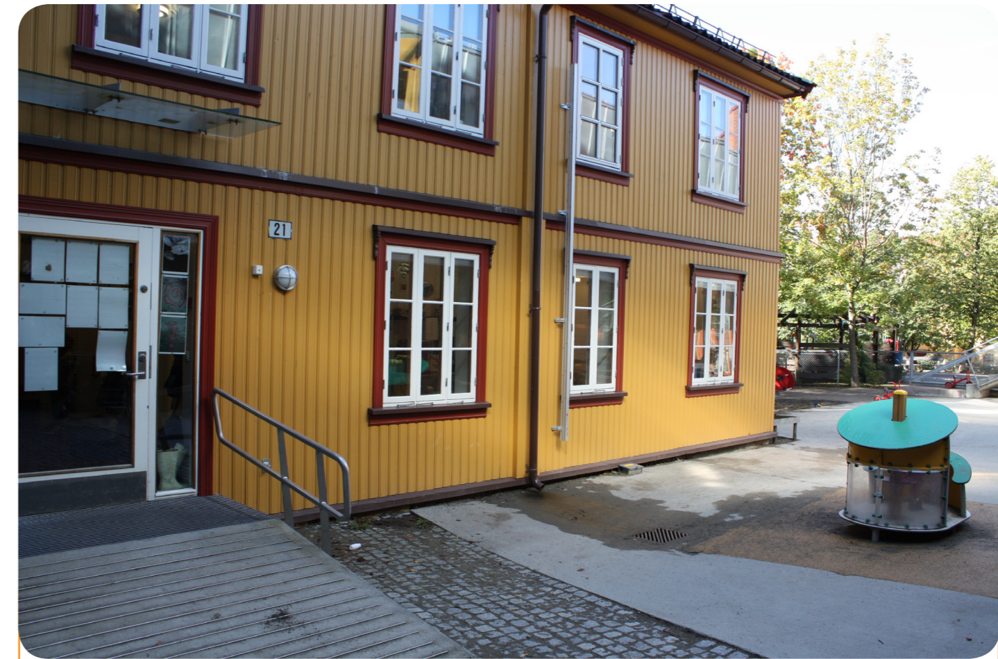
Figur 37. Det gule huset rommer administrasjonen og en barneavdeling
