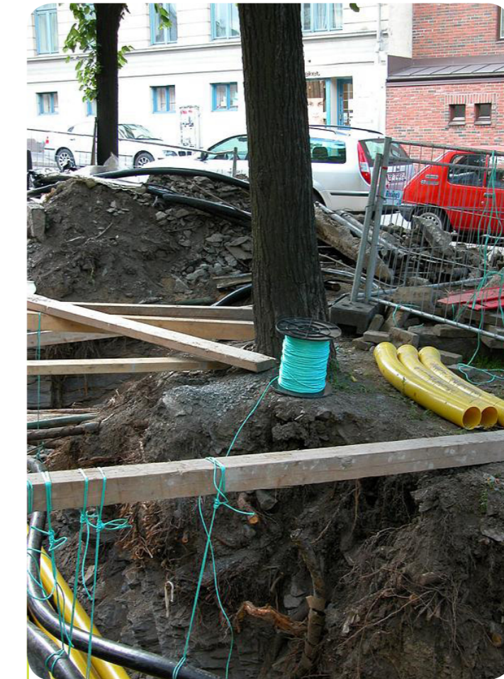
Figur 11. Vern av rotsonen under anleggsarbeid er essensielt for at ikke trær skal skades.
