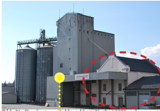
Bilde 21: Den første mølla ble etablert i Vestby i 1920 under navnet Vestby Mølle og Kornsilø AL. Mølla har blitt utvidet og oppgradert med jevne mellomrom og fremstår i dag som et landemerke i sentrum av Vestby tettsted. Stiplet rød linje viser gamle mølla.
