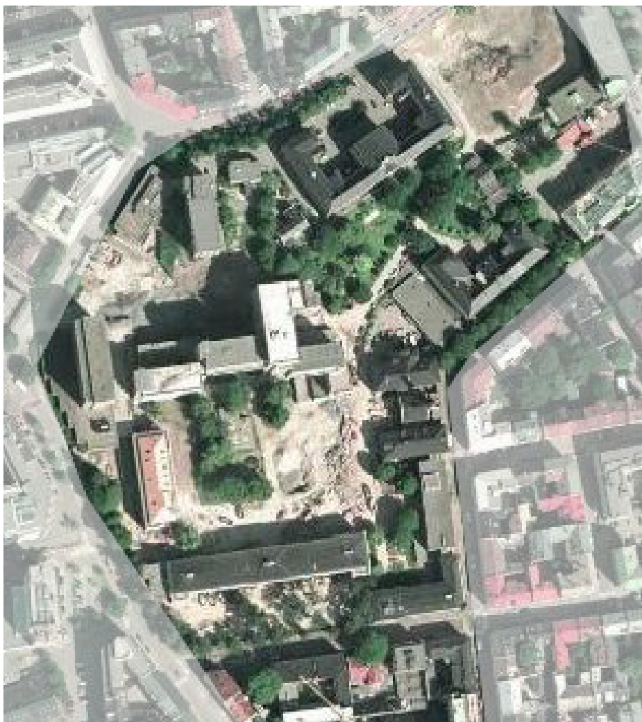
Bilde 32: Området var preget av lite fristende uteoppholdsareal, og tettheten var lav.
