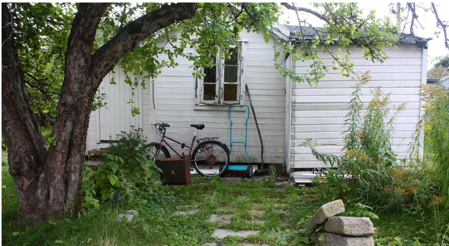
Bilde 29: Eksempel på parsell og hytte som kunne blitt brukt mer, og preges av manglende vedlikehold.
