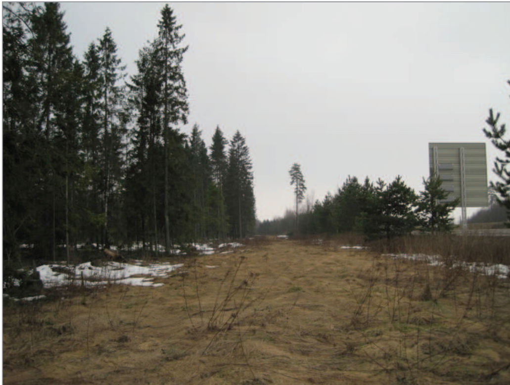
Bilde 3-1: Første del av traséen. Bildet er tatt sørover fra den stasjonære varmesentralen og viser det første rette strekket ned mot trafikkmaskinen med E16 i høyre bildekant (Foto: Reidun M. Romundstad).
