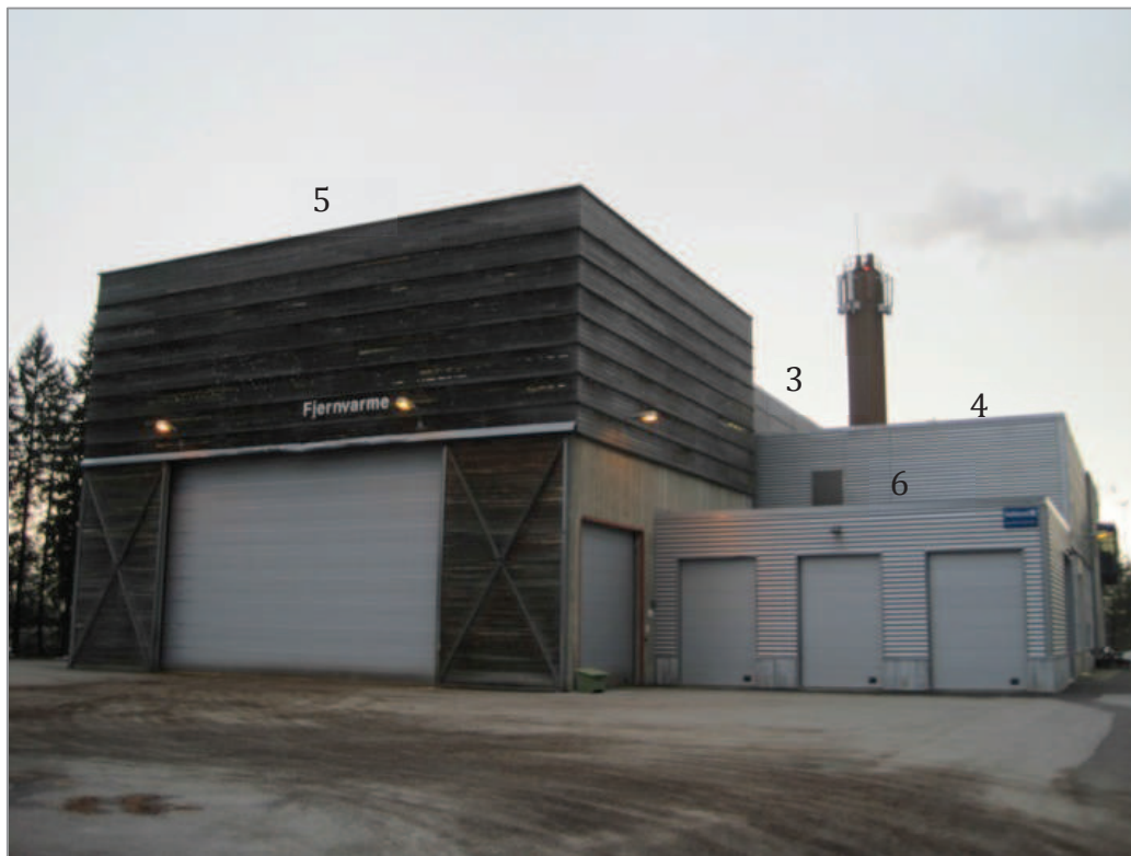
Bilde 3-4: Den stasjonære varmesentralen sett fra nordøst (Foto: Reidun M. Romundstad).
