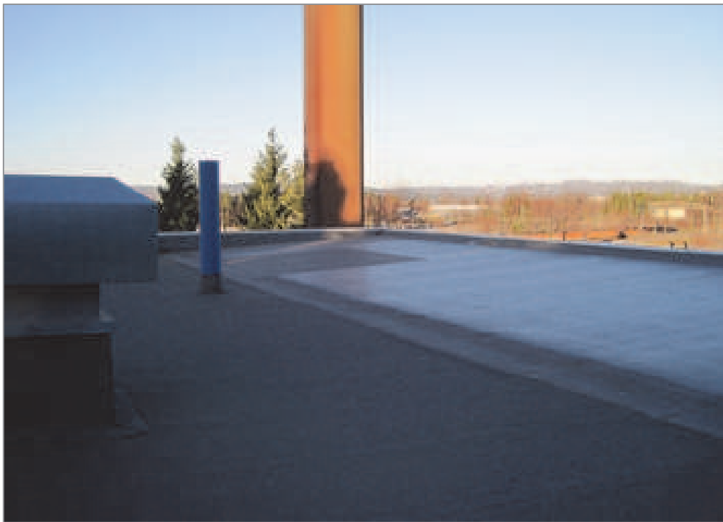
Bilde 3-7: Overgangen mellom takflate 2 og 3. Bildet er tatt nordvestover mot pipen (Foto: Reidun M. Romundstad).
