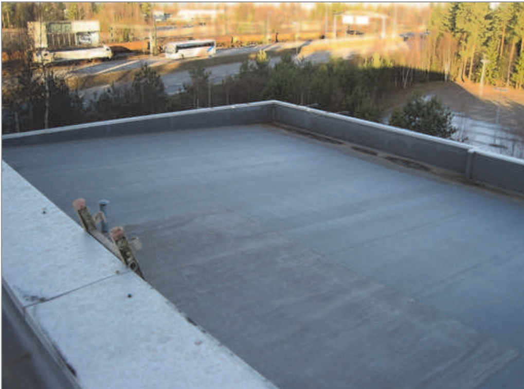
Bilde 3-8: Takflate 4. Denne takflaten ligger litt omtrent tre meter lavere enn takflate 3 (Foto: Reidun M. Romundstad).
