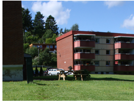
Bilde 4.12: Blokkbebyggelse i Knutseskogen borettslag.
