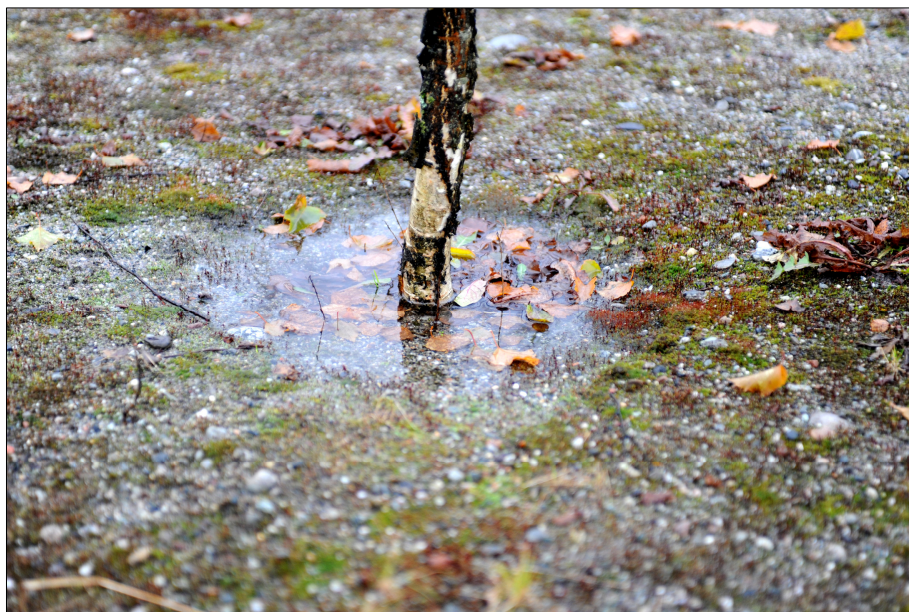
Figur 57. Stående vann pga. dårlig drenering i massene, ble flere steder observert (2.11.12).
